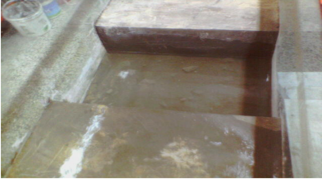
(c) d=0.20 m, B=0.45 m boyutlu model çukuru (Yapım aşaması)
