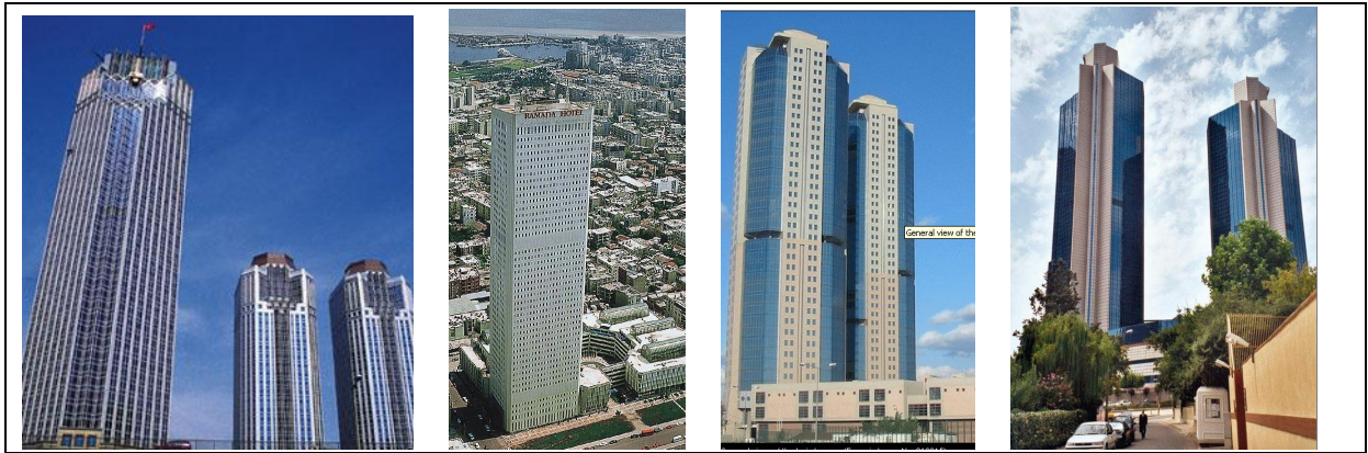
Şekil 2.3 Türkiye’nin en yüksek 4 binası (soldan İş Kuleleri, Mertim, Tekstilkent ve Sabancı Center) [1]
