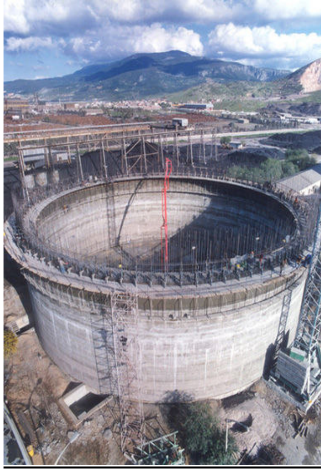
Resim 1.5: Çimentoş klinker silo inşaaı -1994
