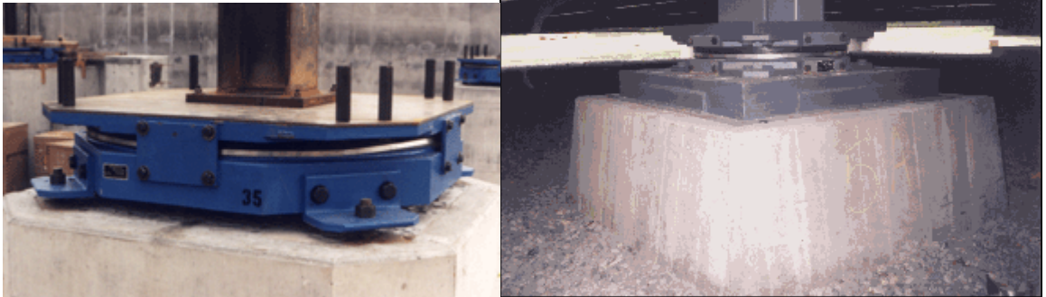
Şekil 5.8 Sürtünme esaslı sismik izolatörlerin uygulama sırasında çekilmiş fotoğrafları (www.earthquakeprotection.com)
