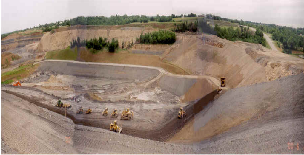
Resim 1.1 Kontroll dolgu yapılan katı atık depolama sahası ( www.epa.gov/msw )
