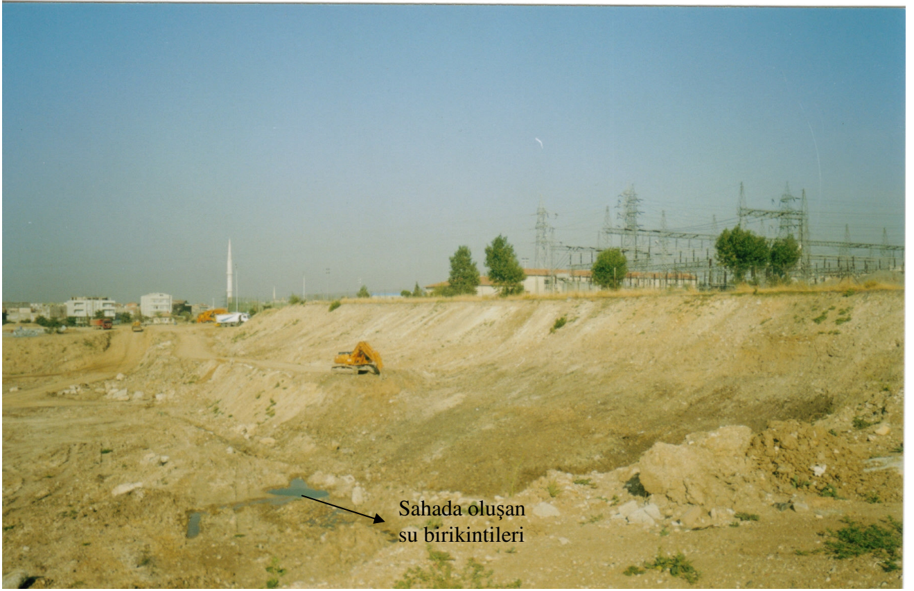
Resim 10.1 Trafo merkezi inşaatının başlamadan önceki ilk halleri.
