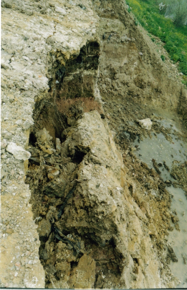
Resim 10.5 Bir duvar kazı sırasında oluşan kayma ve kayma dibinden su çıkışı
