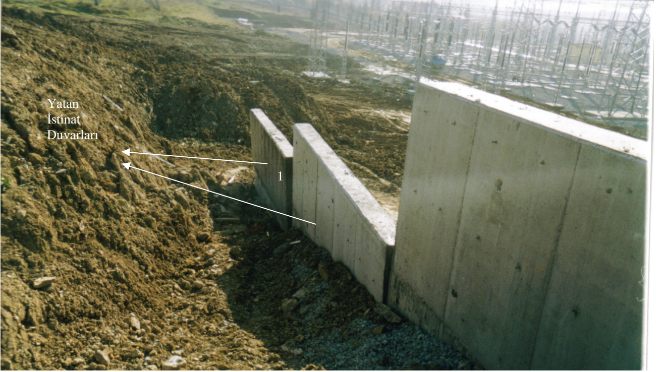
Resim 10.7 B bölgesinde oluşan kayma hareketi neticesinde yatan duvarlar
