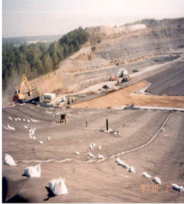
Resim 2.2 Katı atık sahasında yapılan sentetik geçirimsizlik tabakası (www.solid.gov.bb)
