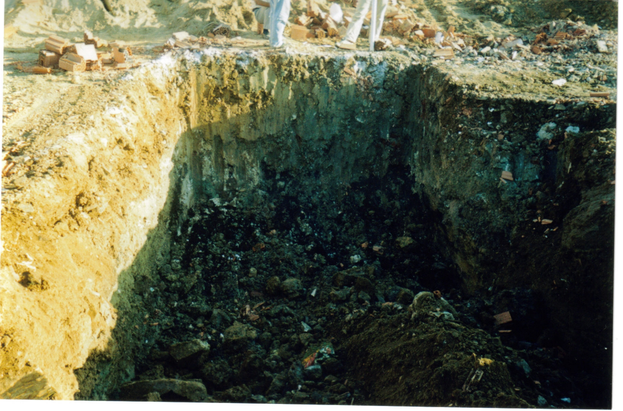
Resim 10.2 Açılan bir temel çukurundaki zemin profili
