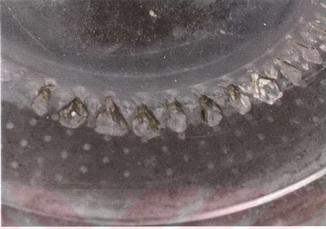
Şekil 7.2 Hasara uğrayan diyafram görüntüsü
