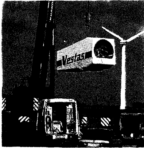
Şekil 6.8 Rüzgar türbininin naselinin (jeneratör yerleşiminin) montajı (Ulusal Rüzgar Gücü Teşkilatının izni ile)
