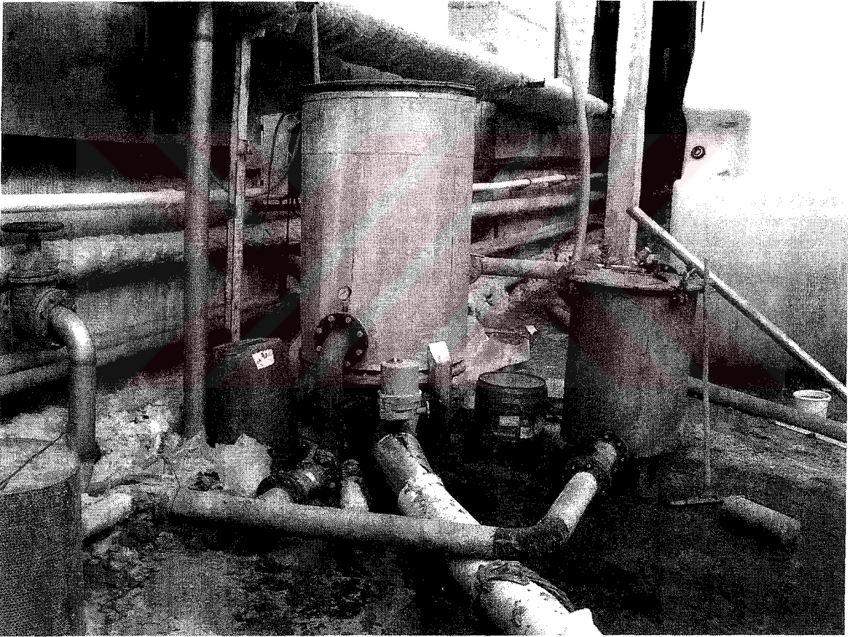
Şekil 5.10 Lüleburgaz ayka tekstilde kullanılan kendini temizleyen otomatik su filtresi.
