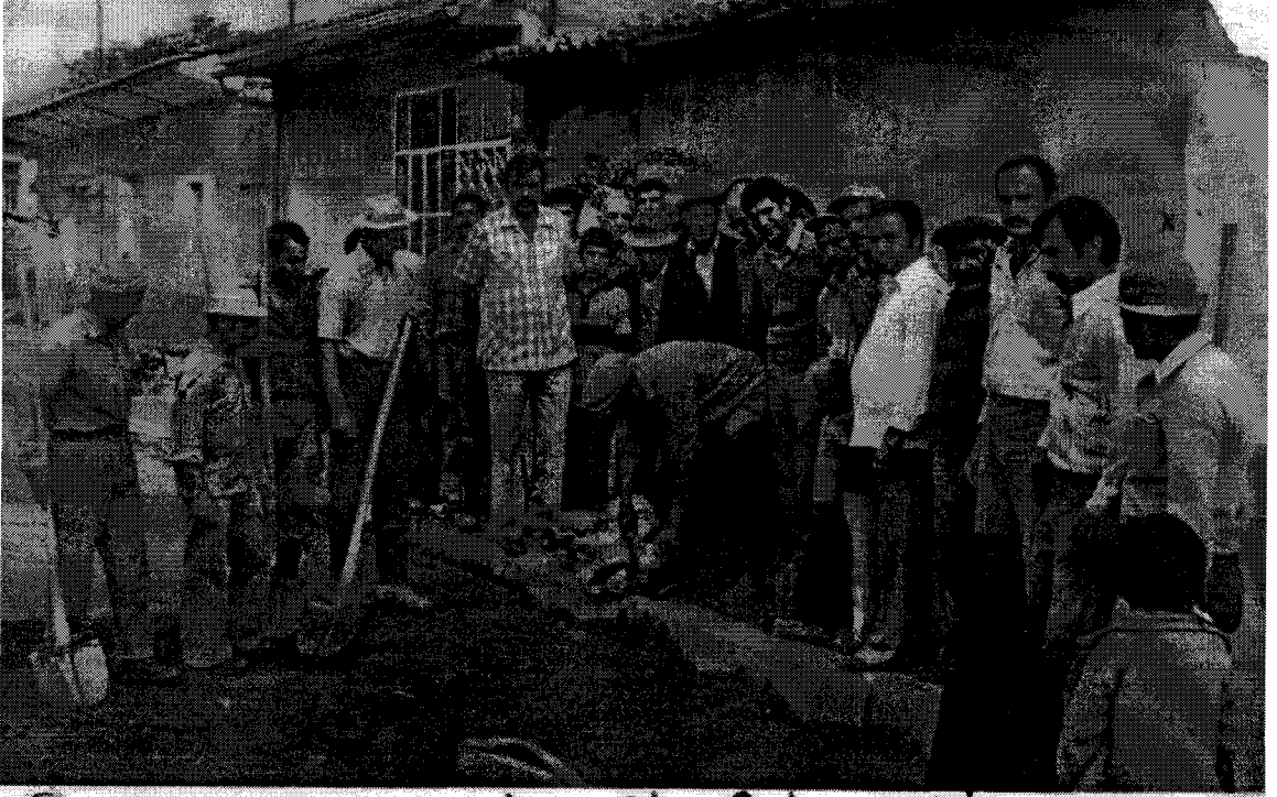
Bengisu Mh. Kılıçaslan Sk. Beton Yol İnşaatı
