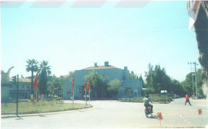
Resim 4.48 Yeni İstasyon Binası, 1940'lı yıllar; bugünkü durumu, (2001).
