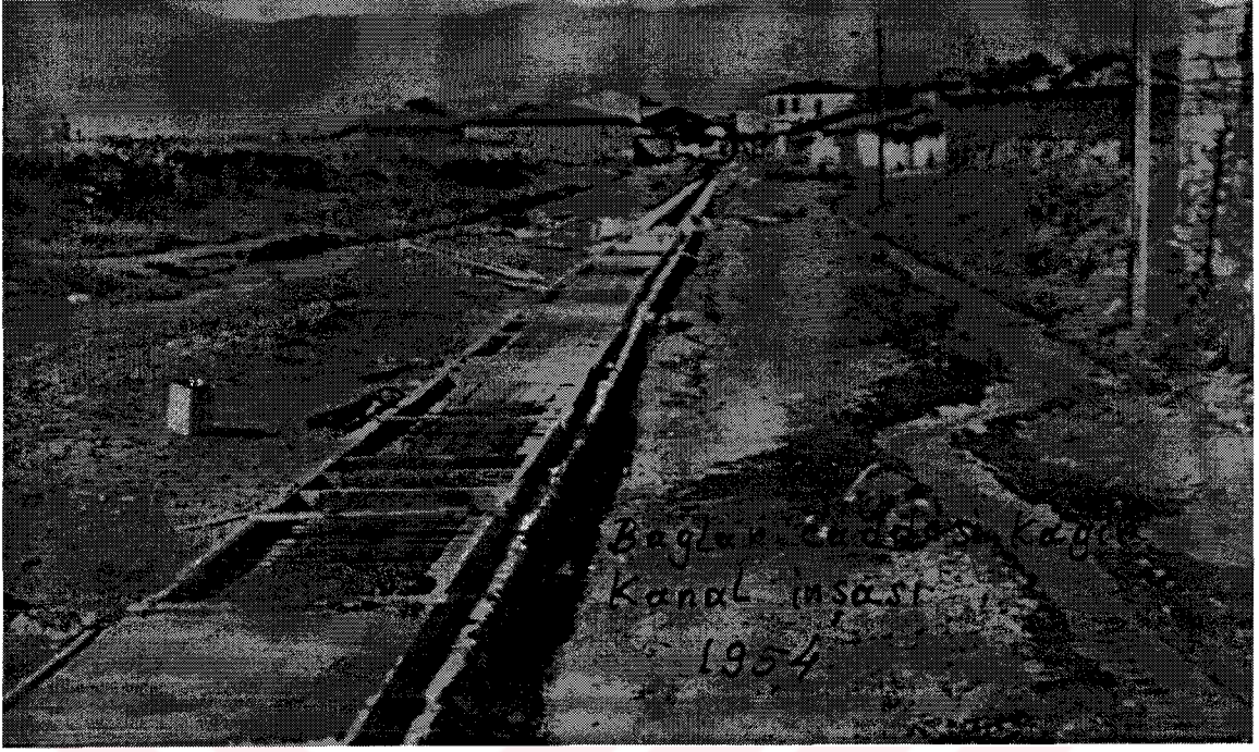
188 Bağlar Caddesi kanalizasyon çalışması, 1954 yılı.
