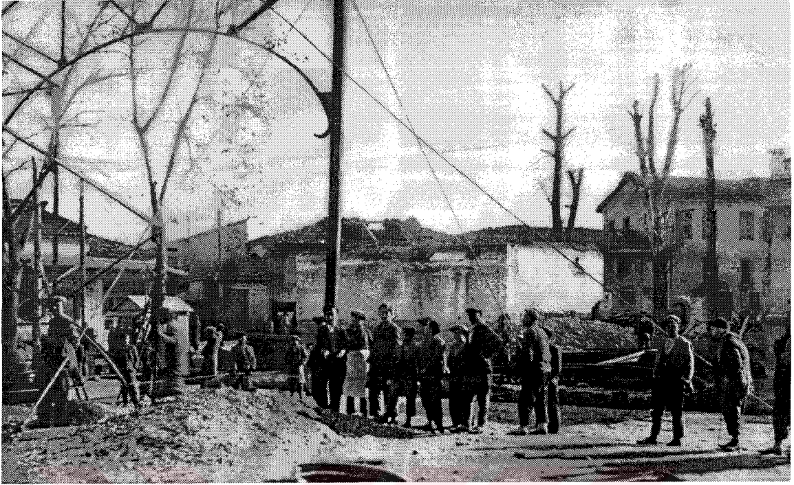
76 Ekin Hali (Pazarı) 'nin yapım çalışmaları, (1927 – 1930).
