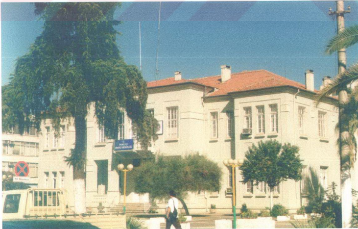
Resim 4.40 Hükümet Konağı (1932); bugünkü durumu, (2001).
