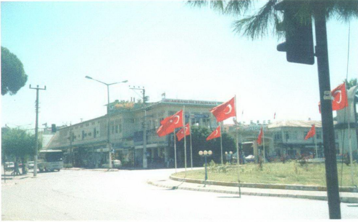
Resim 4.52 Otogar, (1948 – 1956); bugünkü durumu (2001).
