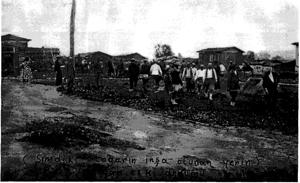
142 Otogar yapılan yerin eski durumu, 1940'lı yıllar.
