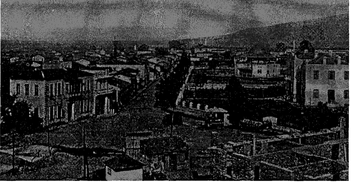
96 Meşrutiyet Caddesi, (1933). Yeni yapılan Reji (Tekel) Binası'nın üstünden çekilmiş.
