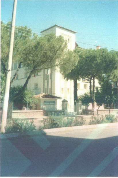
Resim 4.41 Reji (Tekel) binası (1930 – 1932); bugünkü durumu, (2001).
