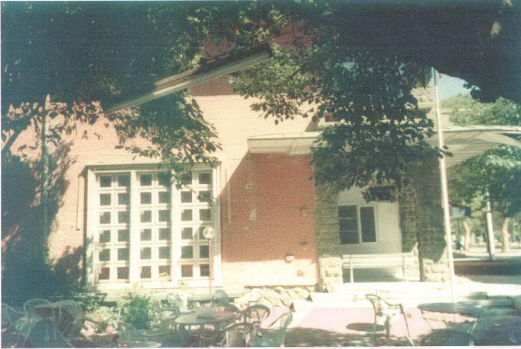
Resim 4.50 Halkevi Binası (1948); bugünkü durumu (2001).
