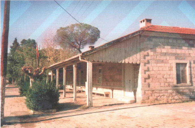
Resim 4.4 Eski İstasyon Binası, (1888); bugünkü durumu, (2001).
