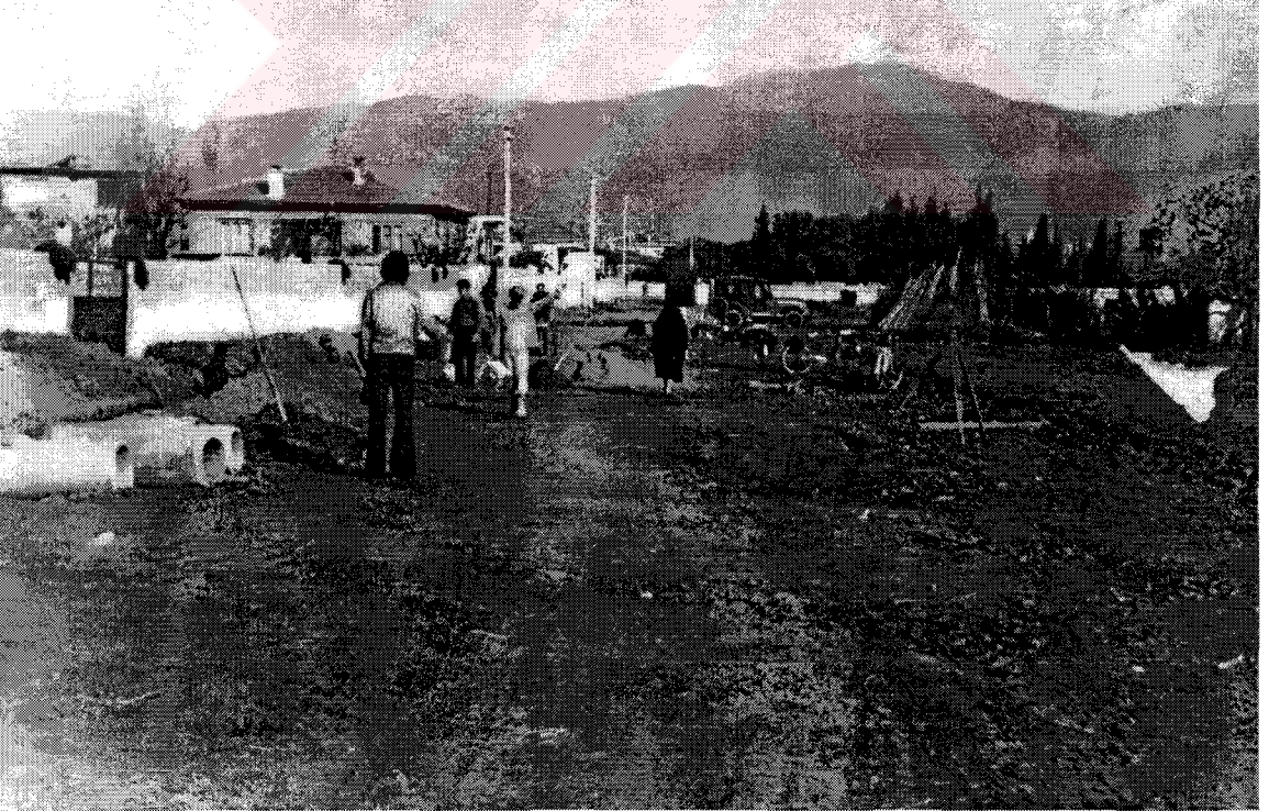
241 Kanalizasyon çalışmaları 1960'lı yıllar.
