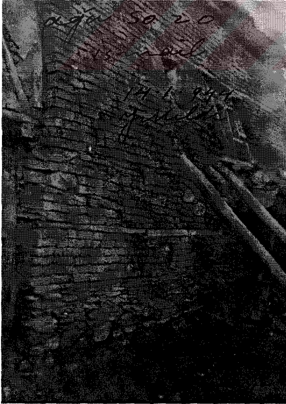
129 Ağa Sokak no:20 , 14.01.1944'te yıkılmadan önceki durumu.
