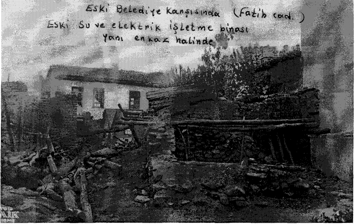
58 Fatih Caddesinde eski su ve elektrik işletme binası yanında yıkılmış evler, (1927 – 1935).
