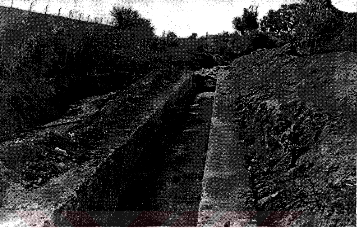
240 Kanalizasyon çalışması, 1960'lı yıllar.
