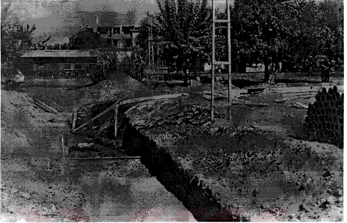
246 Eski İstasyon Mevkii, kanalizasyon çalışmaları 1960'lı yıllar.
