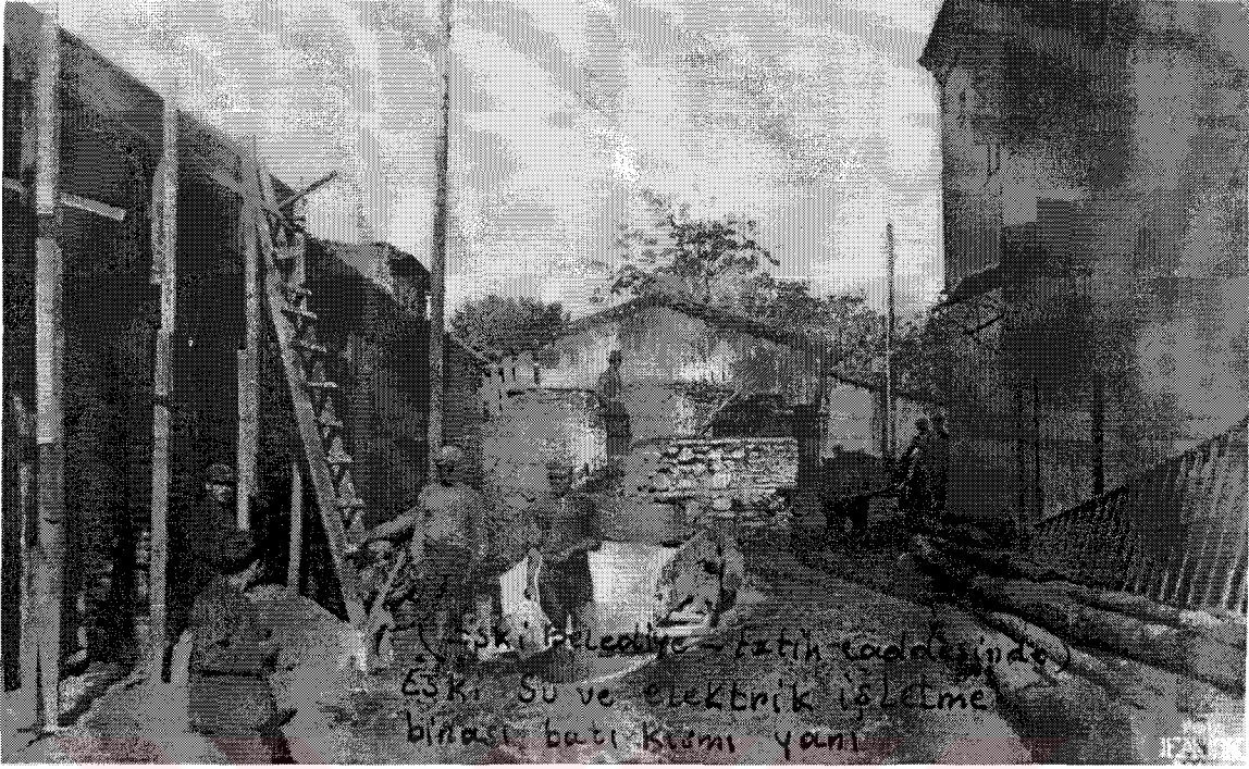
36 Fatih Caddesi'nde, eski belediye'nin elektrik ve su işletme binası batı kısmı yanı Yeni Çarşı'nın yapımı (1927 - 1935).
