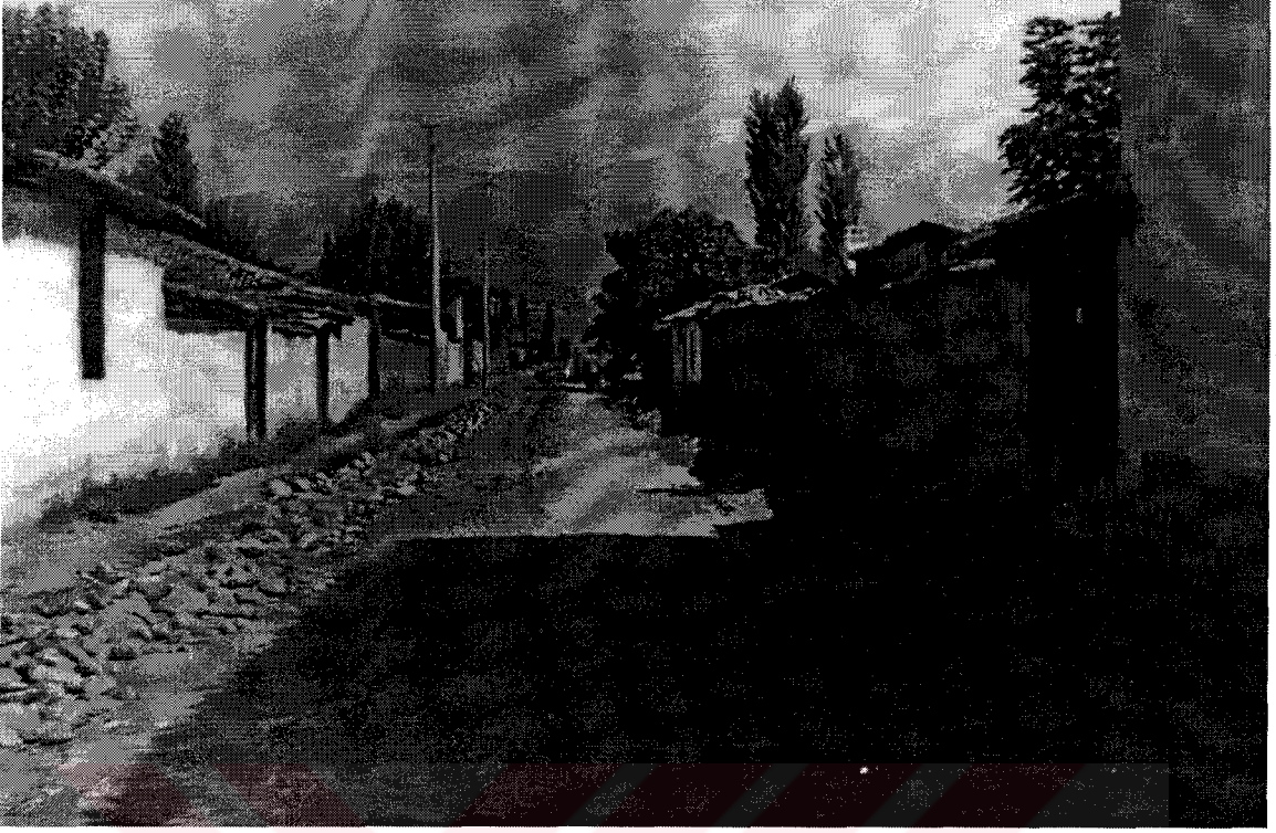
130 Kentte arnavut kaldırımı yapım çalışmaları, 1940'lı yıllar.
