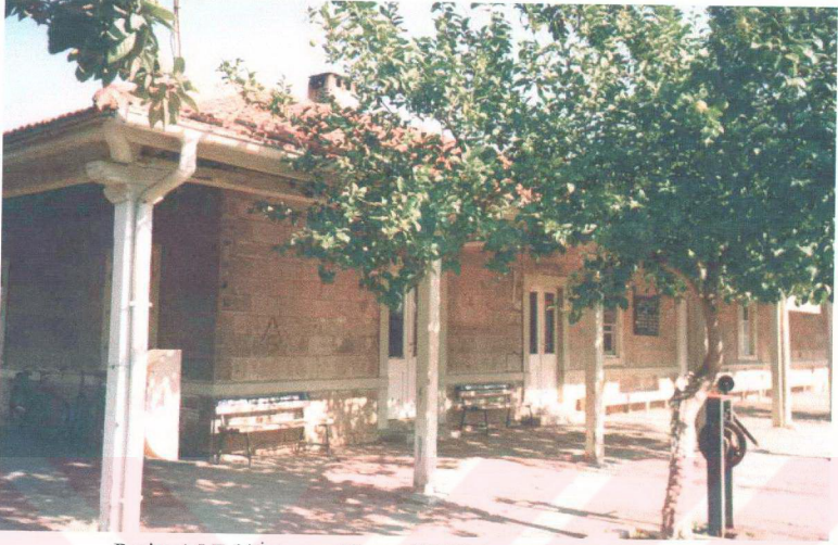
Resim 4.5 Eski İstasyon Binası, (1888); bugünkü durumu, (2001).
