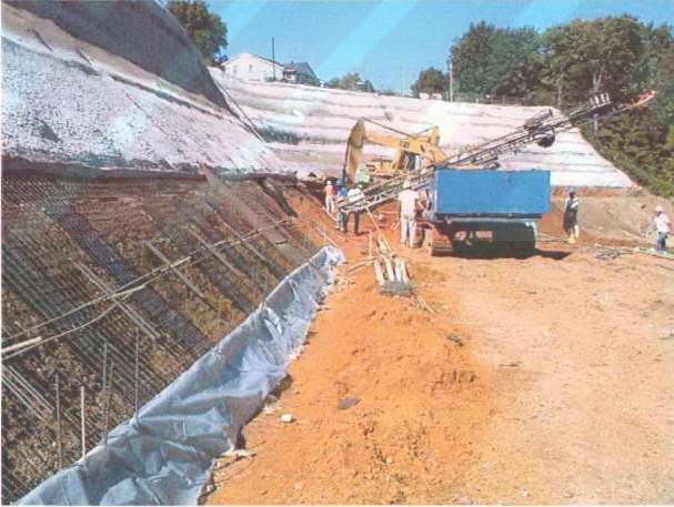
Şekil Ek 1.8 Kaplama donatısının tesisi sonrası görünüm
