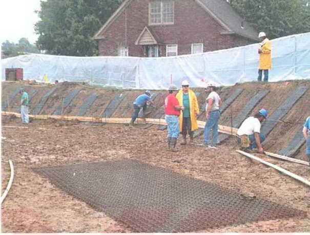
Şekil Ek 1.5 Çivi tesisi sonrasında geokompozit drenaj şeritlerinin döşenmesi ve kaplama donatısının bağlanması
