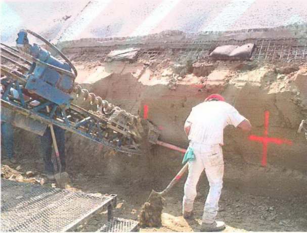
Şekil Ek 1.4 Zemin çivisi tesisi için burgu için delgi yapımı
