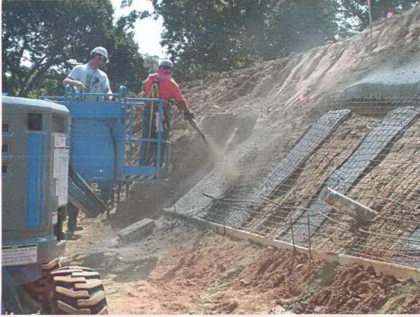
Şekil Ek 1.11 Püskürtme betonun kazı yüzeyine dik olarak uygulanması, ve yatay drenaj borusunun yerleşimi
