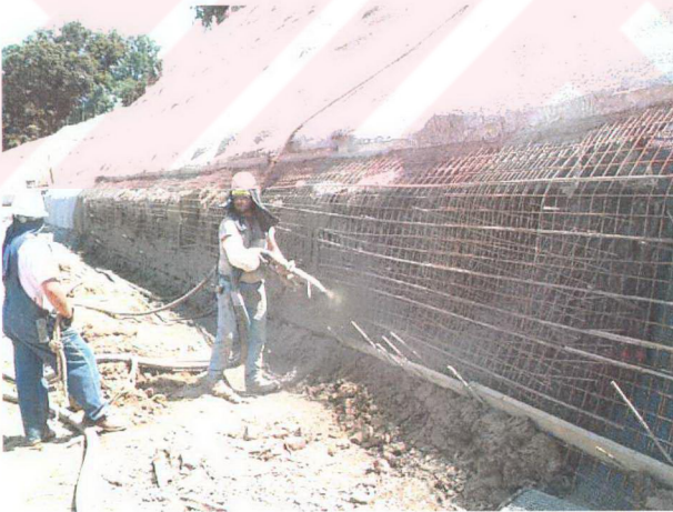
Şekil Ek 1.10 Püskürtme betonun uygulanması
