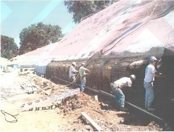
Şekil Ek 1.6 Çivi tesisi sonrasında geokompozit drenaj şeritlerinin döşenmesi ve kaplama donatısının bağlanması
