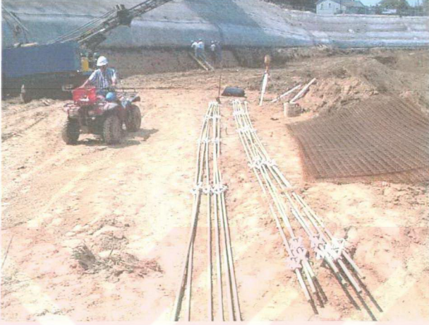
Şekil Ek 1.1 Zemin çivisi ve kaplama donatısı olarak kullanılacak hasır çeliğin şantiyede uygunsuz şekilde istiflenmesi.
