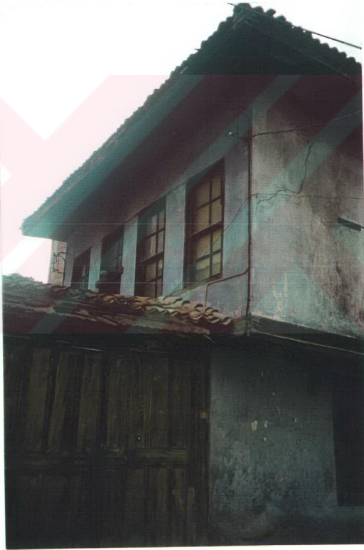
Resim 8.19 Evin bahçesine açılan büyük tahta kapı yer alıyor. Fotoğrafta görülen oda, baş oda. Yol tarafında ve bahçe tarafında çıkma yapılmış. Çıkmayı payandalar taşıyor. Yol cephesinde pencere açılmamış.
