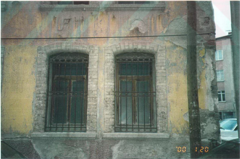
Resim 8.54 Alt katın oturma odasının pencereleri. İçe açılan çift kanatlı pencerelerin orijinali üst katlarda olduğu gibi giyotinmiş. Demir parmaklıklar hırsızdan korunmak için.
