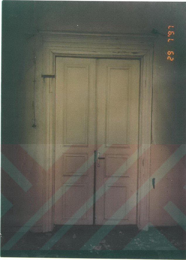
Resim 7.8 oda kapılarından birinin fotoğrafı. Kapılar çift kanatlı ve aynalı. Malzemesi ahşap. Kasanın çevresinden geniş pervaz dönüyor.
