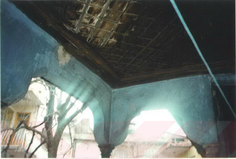
Resim 8.25 Ahşap direkler üzerinde taşınan sofanın tavan kaplaması.
