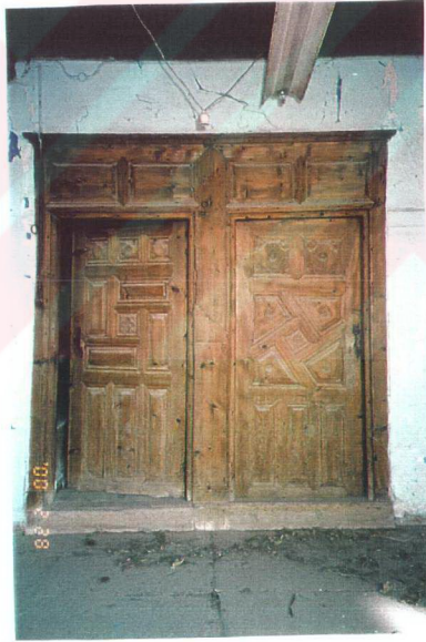
Resim 8.4 Alt katın orta odalarının kapıları. Kapıların sofa tarafından görünümü. Sofa tarafı oymalı yapılmış, oda tarafı sade. Kapılar iç tarafta, dolap dizisinin içinden açılıyor. kapıların üzerindeki taç ile kapı olduğundan daha yüksek gösteriliyor.
