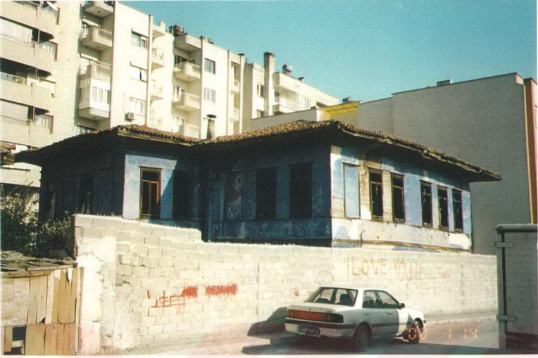
Resim 8.15 Kurşunluoğlu ailesi bakımı zor olduğu için evin önünde bulunan apartmana taşınmış. Eski ev boş ve bakımsız halde duruyor.
