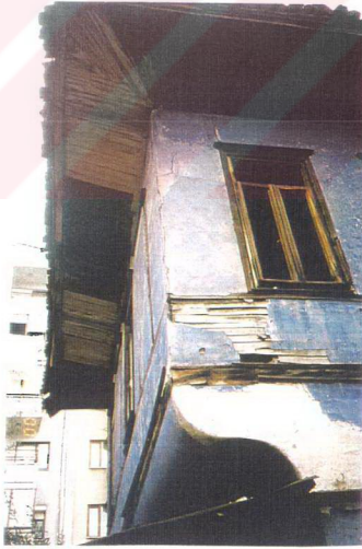
Resim 8.16 Evin strüktürünün görüldüğü detay fotoğrafı.Çivit mavisi evin orijinal rengi.
