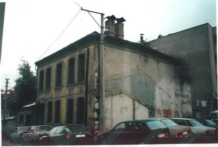
Resim 8.53 Yoldan görünüş. Pencereleer duvarın iç kısmında yer alıyor. Önlerinde geniş bir denizlik var. Sağır duvardan anlaşılacağı üzere eskiden bu cephede başka evler yer alıyormuş. Yol açılırken yıkılmış olmalı. Tuvaletlerin olduğu bölüm, çatıdaki kot farkıyla anlaşılabilir.
