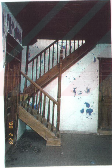
Resim 8.2 Sofanın köşesinde yer alan merdiven ahşaptan yapılmış. Limon kiriş üzerine bindirme ahşap basamaklar. Merdiven altı ahşap kaplama. Merdiven korkulukları da ahşaptan yapılmış.
