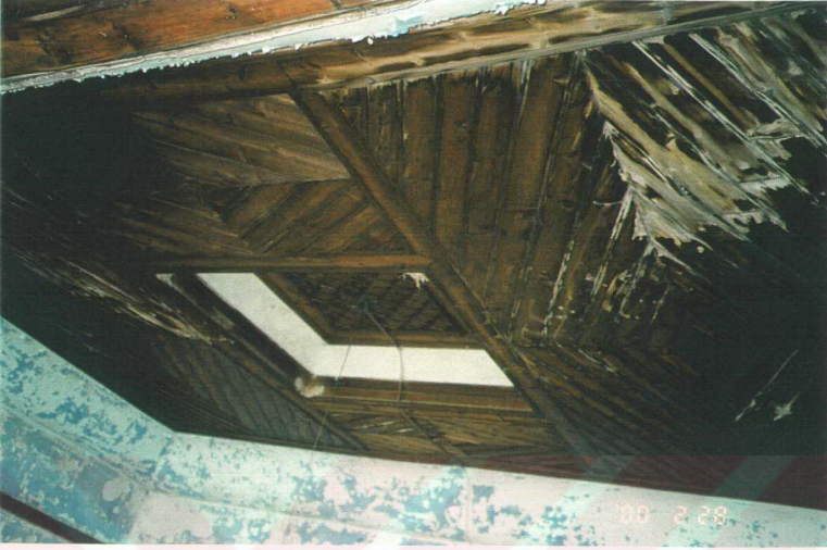
Resim 8.11 Birinci katın sofasının tavan kaplaması. Ön tarafta yer alan sofa çıkmasında tavanda kot farkı yapılmış. Tavan kaplamasının ortasında yine kot farkıyla göbek var. Tavan kaplaması, ince çitelerin diyagonal yapıştırılmasıyla elde edilmiş.
