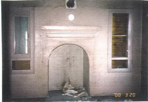
Resim 8.49 Alt kattaki odanın ocağı ve dolapları. Dolap kapakları aynadan yapılmış.
