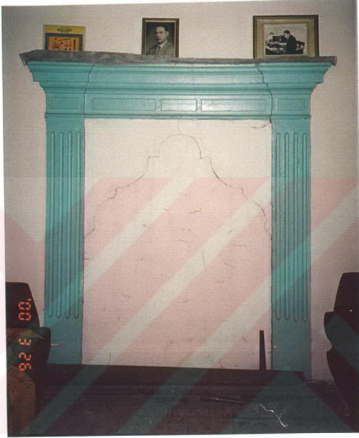
Resim 8.36 Sağ yan odadaki ocağın fotoğrafı. Mavi ile boyalı olan yerler mermerden yapılmış. Ocakların hepsinin üzerinde konsollar bulunuyor.
