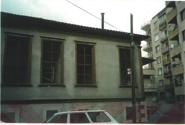
Resim 7. 5 Tek katlı evlerin terk edilmesinin başlıca sebeplerinden olan apartmanlar evin çevresinde görülüyor. İbrahim Oklu arşivi.
