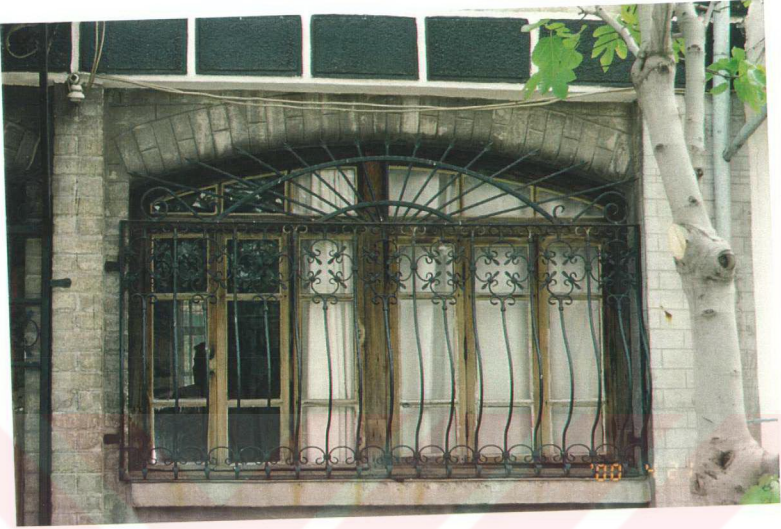
Resim 8.61 sofanın pencerelerinden biri. Sofa tarafının duvarları daha ince yapılmış.
