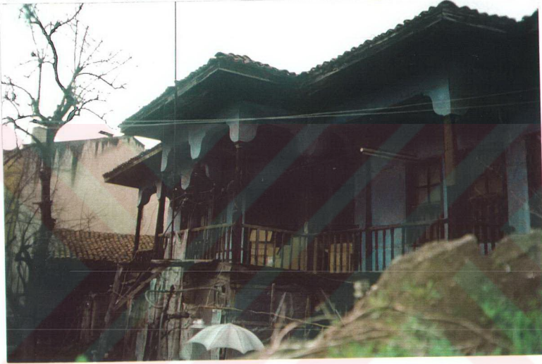
Resim 8.18 Sofa bahçe tarafına bakıyor. Bütün odaların pencereleri sofaya açılıyor. sofanın çatısını ahşap direkler taşıyor. Direklerin altı ahşap korkuluklarla, üstü bağdadi kemerle bağlanmış.
