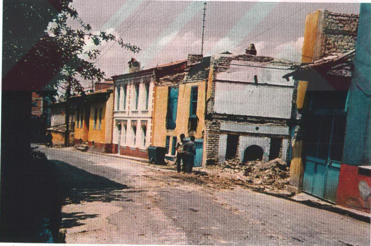
Resim 6.1 Çaybaşı mahallesindeki evler yıkılırken çekilmiş bir fotoğraf. Yıkılmış olan ev Şoğlu evi. Hamza Tınastepe'nin arşivinden.
