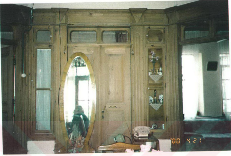
Resim 8.63 Yan odaların kapıları ve orta odanın kapısı yer alıyor. Orta odanın kapısının iki yanında dolaplar yer alıyor. Birisi sofadan diğeri odadan kullanılıyor. Kapların iki yanına geniş pervazlarla kolon havası verilmiş. Üzeri çiçek işlemeli.
