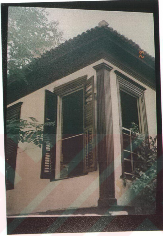
Resim 7.7 giyotin pencerelerin panjurları ahşaptır. Evin köşelerinde bulunan yivli ahşap kolonlar binaya belirli bir estetik değer katmaktadır.
