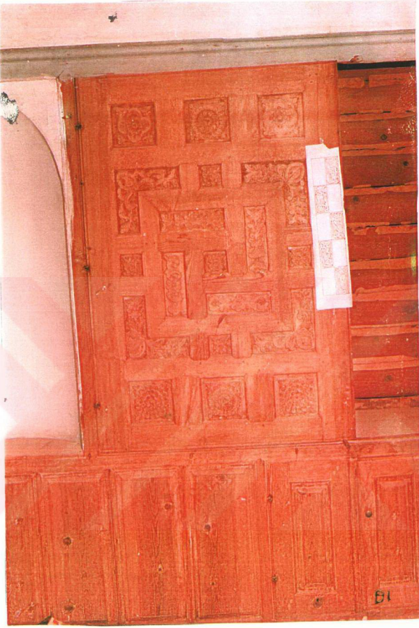
Resim 6.13 Dolap kapakları ahşap işlemeli. Yükseklikleri üst sınıra kadar yükseliyor. Alt kısım sabit yapılmış. Üst kısımda niş, gusülhane ve yüklük bulunuyor.
