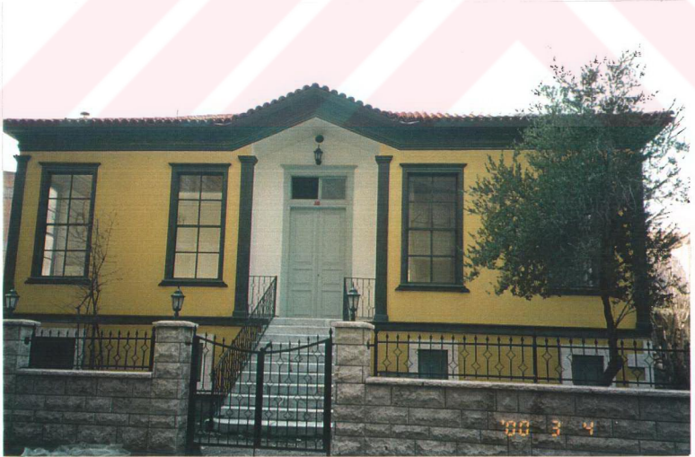
Resim 7.4 Restorasyon sırasında evin girişinden çekilmiş bir fotoğraf (2000).
