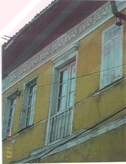
Resim 8.68 üst katın detay fotoğrafı. Sofanın penceresinin üstünde evin yapılış tarihi yazılı. Ahşap pencerelerin orijinali giyotinmiş. Binanın bitişinde yaprak motifleri yer alıyor. Saçak altı kaplaması ahşap.
