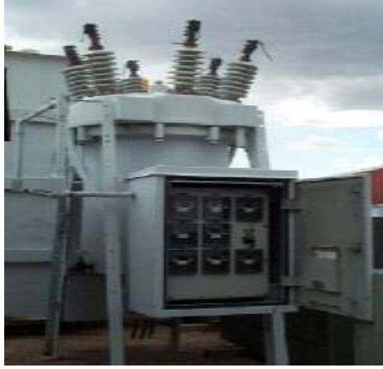
Şekil 6.2 Yağlı kesici.
