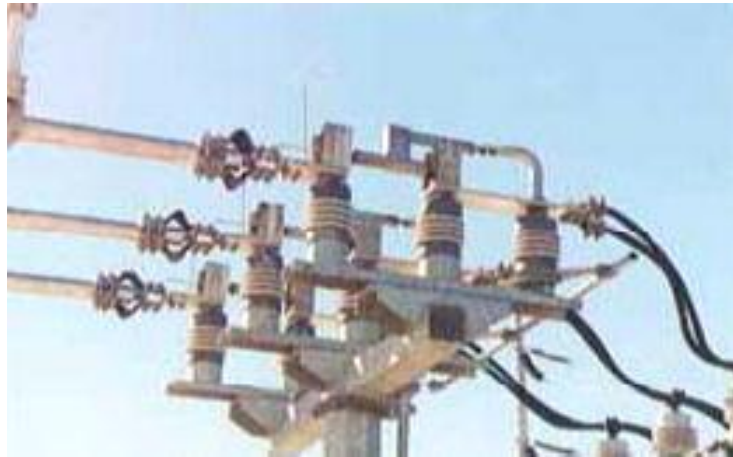
Şekil 6.1 Havalı kesici.
