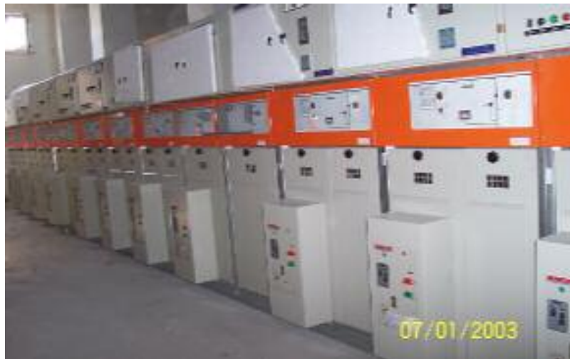
Şekil 3.5 SF6 gaz izoleli modüler hücreler.
