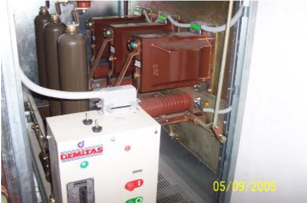
Şekil 6.4 SF6 gazlı kesici.
