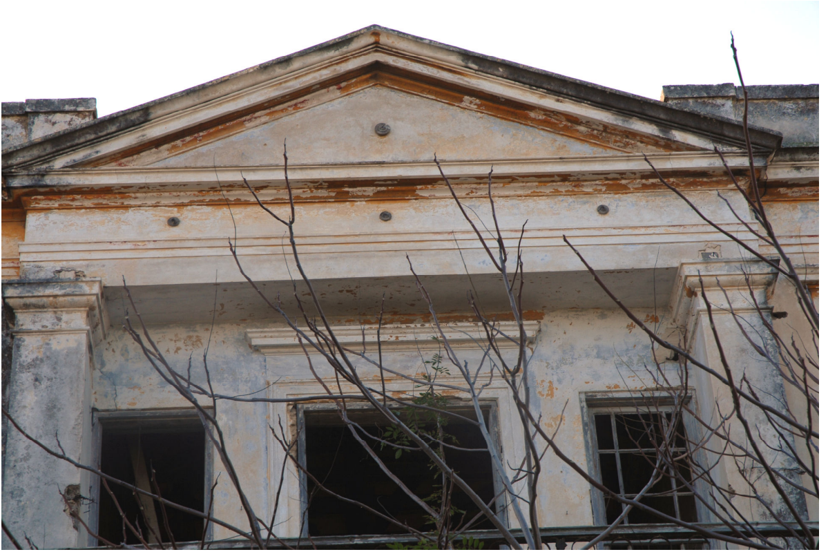
Fotoğraf 5.15 Katalog 1'deki Akkavi Evinin cephesindeki üçgen alınlığı
