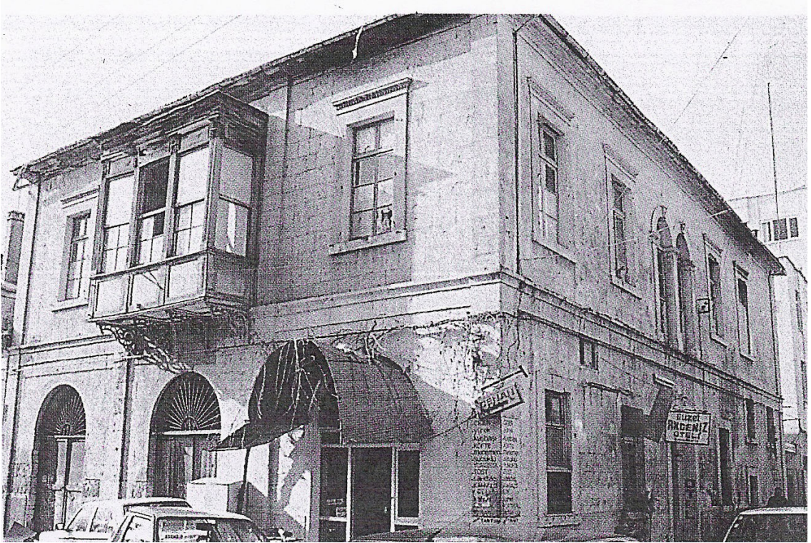
Fotoğraf 6.26 Mersin Akdeniz Otelindeki ahşap kapalı çıkma ve çıkmayı taşıyan metal payanda (Yenişehirlioğlu,1995:63)
