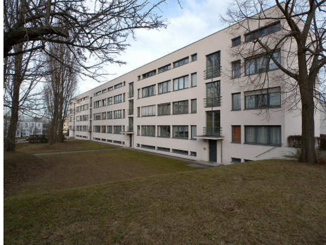
Şekil 5.4 Mies van der Rohe' nin Weissenhofsiedlung'da tasarladığı konut bloğu görünüşü
