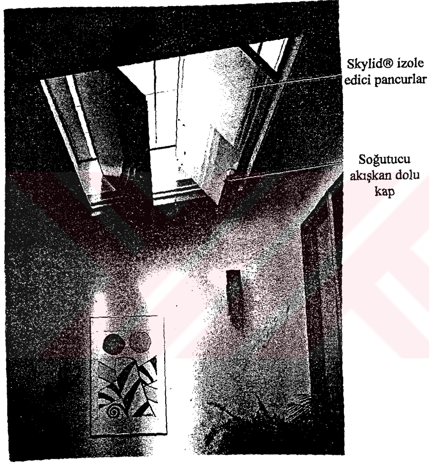
Şekil-4.20. Skylid® izole edici pancurlar, solar radyasyonu kontrol edecek ve skylight ile oda arasında izolasyon engeli oluşturacak şekilde skylightların altında kullanılırlar.
