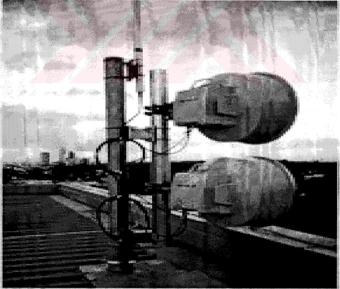
Şekil 18.3 Entegral antenli mikrobaz istasyonları
