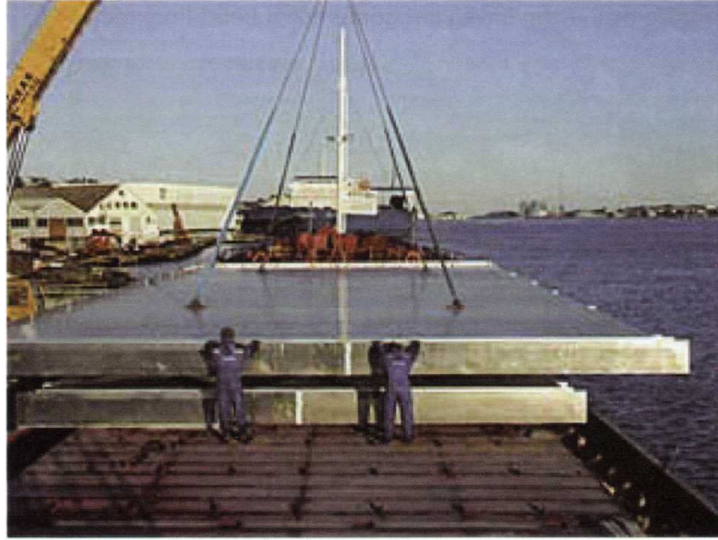
Şekil 4. 8 Hyro Marine Alüminyum tarafından üretilmiş "The World" yolcu gemisine ait güverte panelleri
