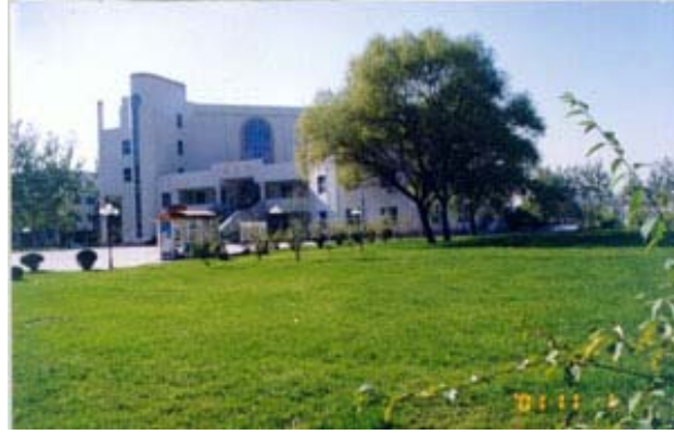
Şekil Ek 1.62 Huabei Power Plant [126].
