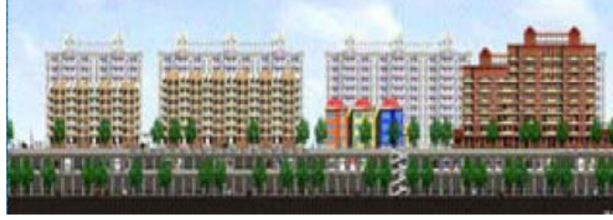
Şekil 4.23 Çin’de metro istasyonu üzerine inşa edilen kauçuk sismik taban yalıtımlı binalar (Saito, 2007)
