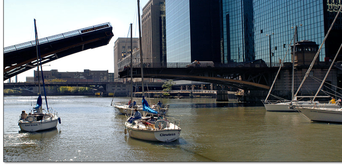
Şekil 3.32 Jackson Street Bridge [27].
