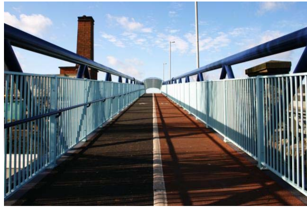
Şekil Ek 1.98 Coldhams Lane Bridge [149].
