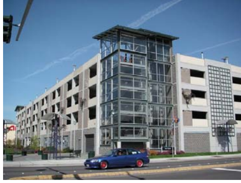
Şekil Ek 1.45 Kent Parking Garage [111].
