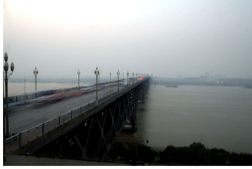
Şekil Ek 1.61 Nanjing 3 rd Crossing Bridge [125].
