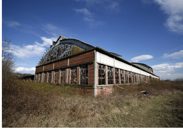
Şekil 3.17 Steel Mill Project [2].
