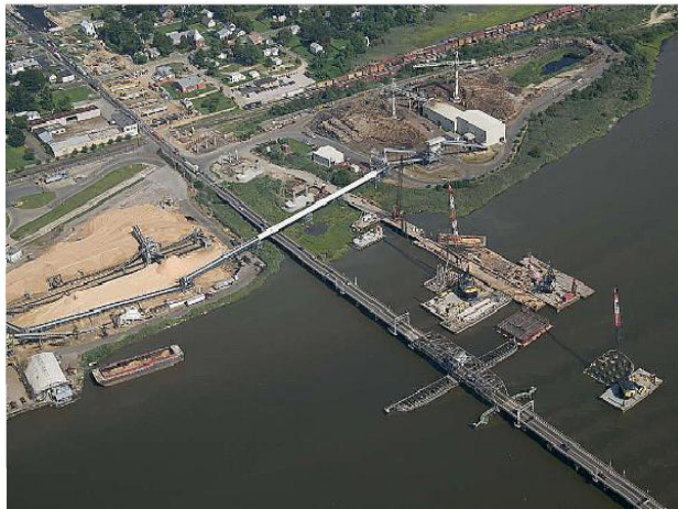
Şekil Ek 1.41 Pamunkey River Bascule Bridge [107].
