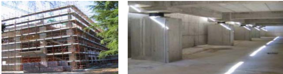
Şekil 4.33 Gervasutta Hospital ve kauçuk taban yalıtkanlar (Saito, 2005).
