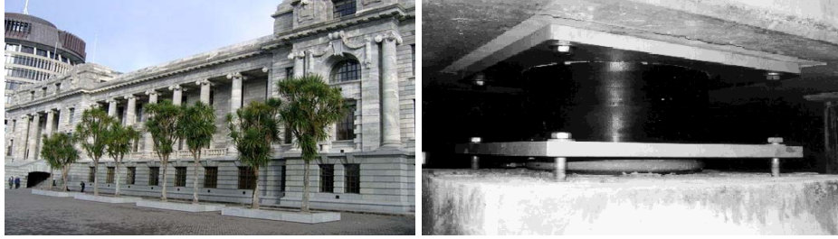
Şekil 4.12 Parliament House ve yapıda kullanılan sismik taban yalıtkanı (FEMA, 2005).
