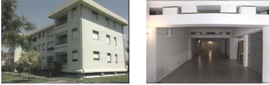
Şekil 4.31 İtalya’da kauçuk sismik taban yalıtımlı ilk konut (Saito, 2005).
