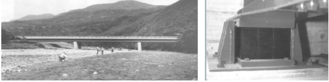
Şekil 4.17 Miyagawa Bridge ve yalıtım detayı (Ervin, 2002).
