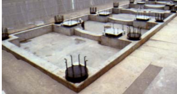
Şekil 4.52 Yalıtkanların temel seviyesinde yerleşimi (Coşkun, 2005).
