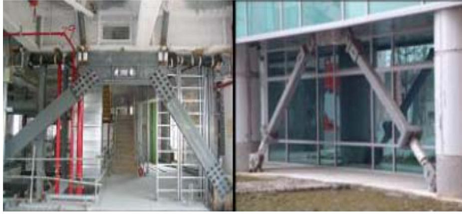
Şekil 3.24 Taishin Bank Headquarters’ın iç ve dış çerçevesinde kullanılan viskoz akışkanlı sönümleyiciler [20; Hwang, 2002].
