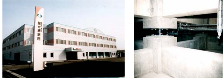
Şekil 4.18 Kyorin University School of Medicine ve yalıtım detayı (Saito, 2005).
