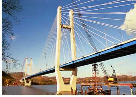
Şekil Ek 1.4 William H. Harsha (Maysville Bridge) [67].
