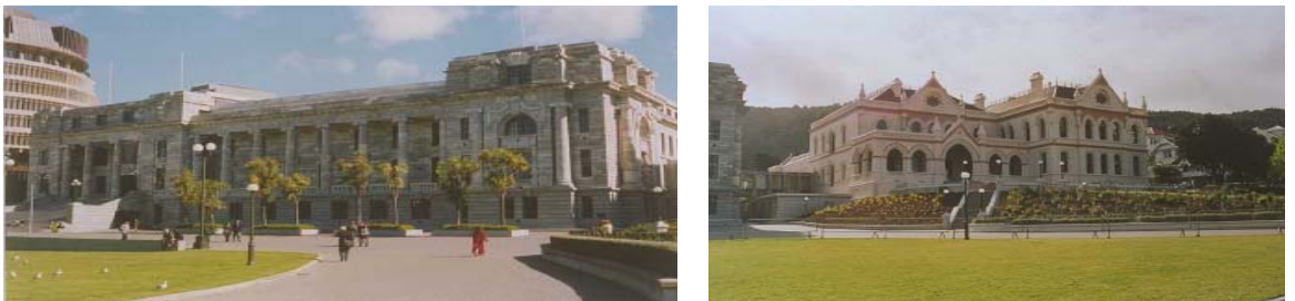
Şekil 4.13 Assembly Library'nın güçlendirilmeden önceki ve sonraki durumu (Robinson, 2000; [45]).
