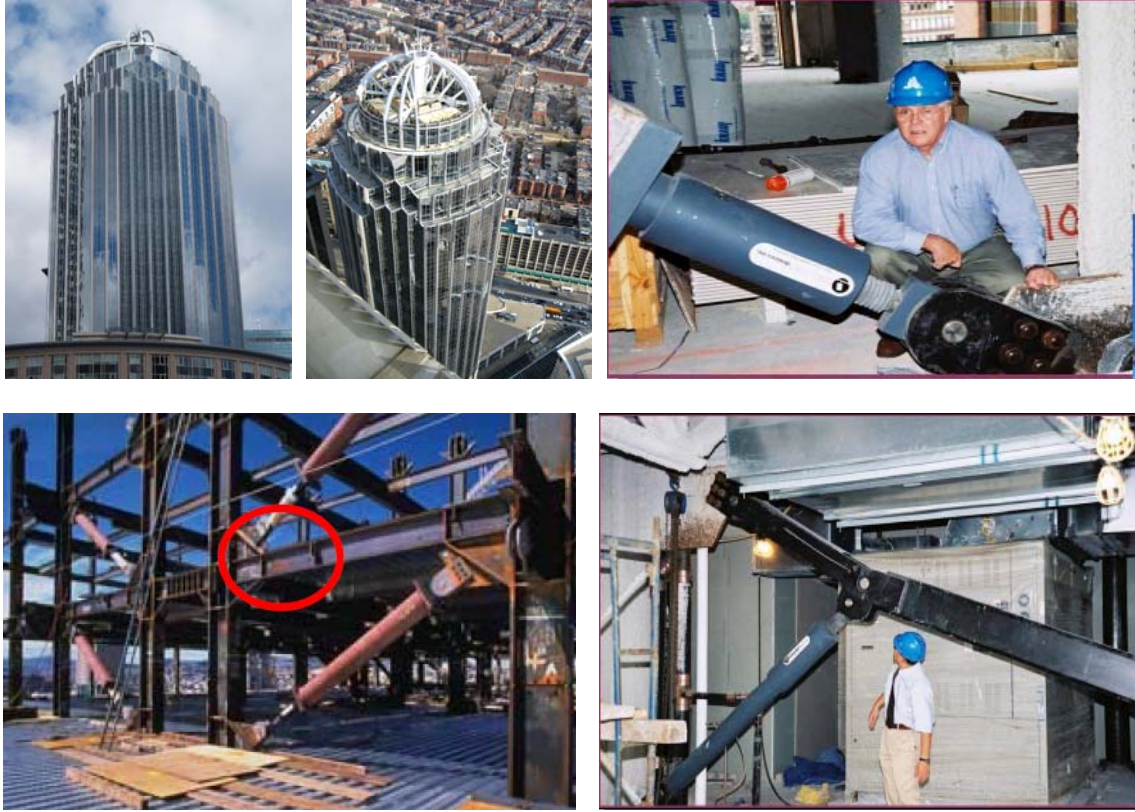
Şekil 3.7 111 Huntington Avenue ve yapıda kullanılan sönümleyiciler [2; 3; 4; FEMA,2003].
