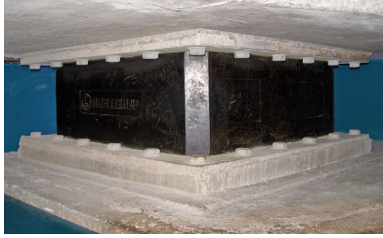
Şekil 4.14 Te Papa - Museum of New Zealand ve yapıda kullanılan kauçuk taban yalıtkanı (Robinson, 2000; [46]).
