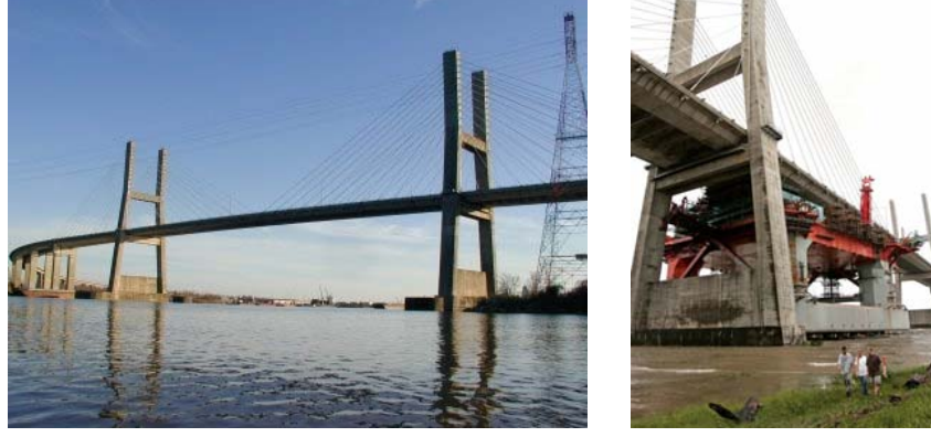
Şekil Ek 1.23 Cochrane Bridge [86; 87].
