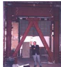
Şekil 3.5 Hotel Woodland ve yapıda kullanılan viskoz akışkanlı sönümleyici [2].
