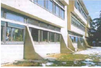
Şekil 4.2 Pestalozzi İlkokulunda ilk kauçuk yalıtkan uygulaması (Apostolska, 2006).
