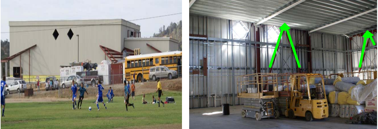
Şekil 3.12 Don Pedro High School ve yapıda kullanılan viskoz akışkanlı sönümleyiciler [11].
