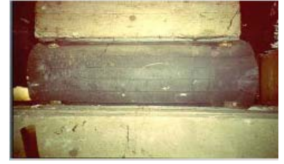
Şekil 4.2 Pestalozzi İlkokulunda ilk kauçuk yalıtkan uygulaması (Apostolska, 2006).
