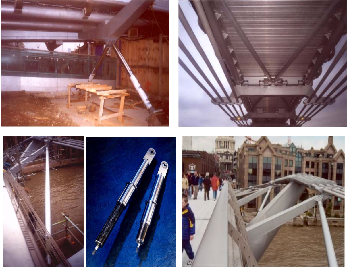
Şekil 3.27 Millennium Bridge, eski-yeni hali ve kullanılan viskoz akışkanlı sönümleyici [2;22].
