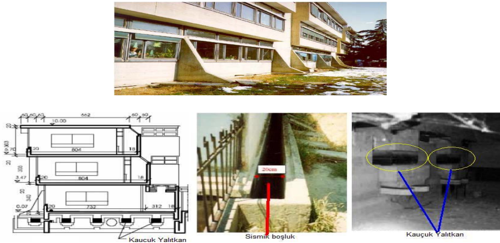
Şekil 4.26 Pestalozzi İlkokulu ve kullanılan sismik taban yalıtkanları (Saito, 2005).
