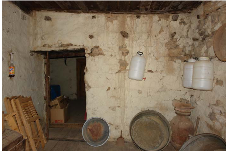
Şekil 5.19 Oda (103) giriş kapısına doğru bakış
