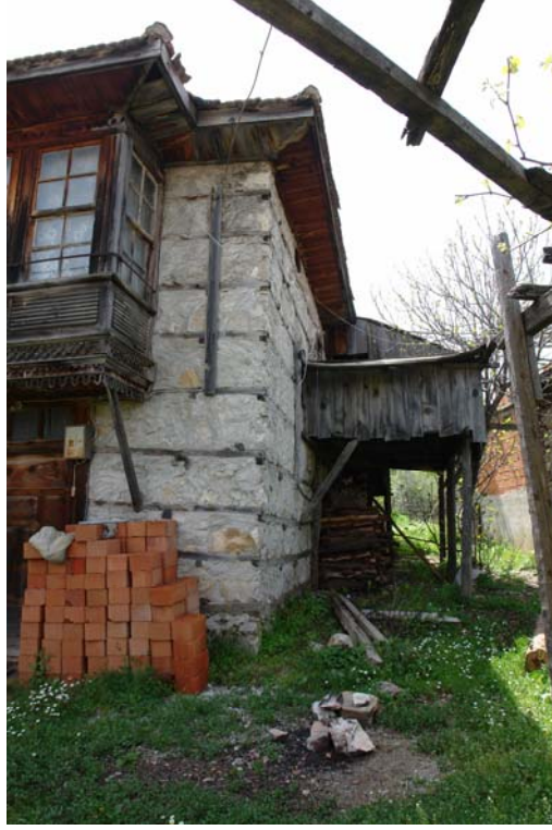
Şekil 4.46 Saçak altı kaplaması olan alttan tavanlı çatı
