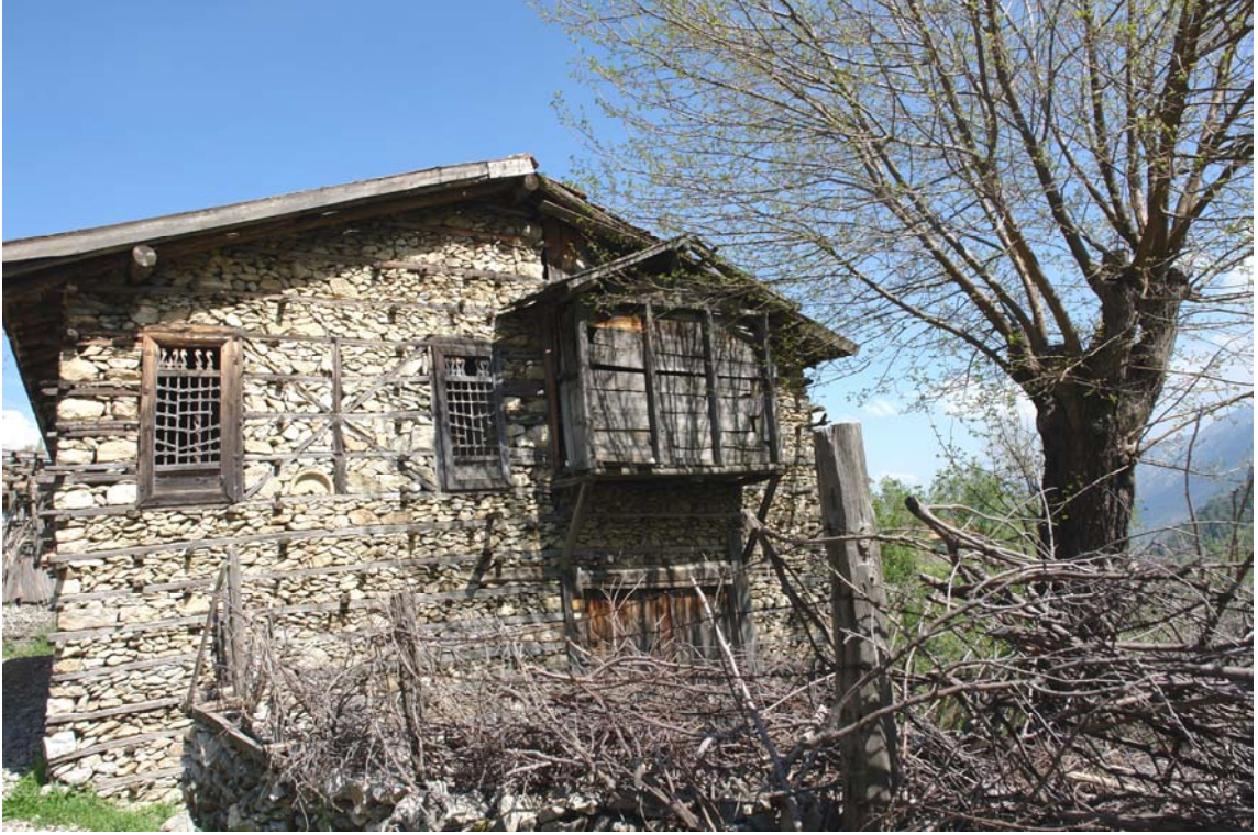
Şekil 4.32 Geleneksel Ürnlü evinde üçgen alınlıklı, payandalarla desteklenen çıkma
