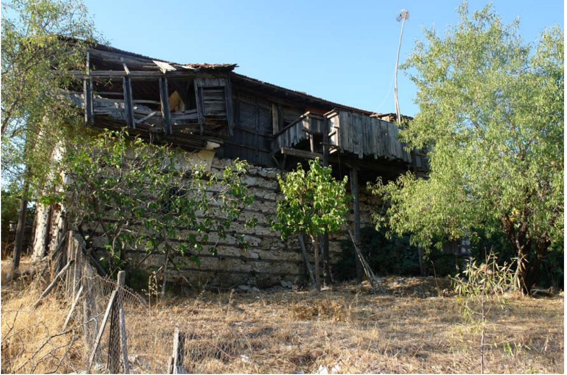
řekil 5.45 Yapının dođu cephesi
