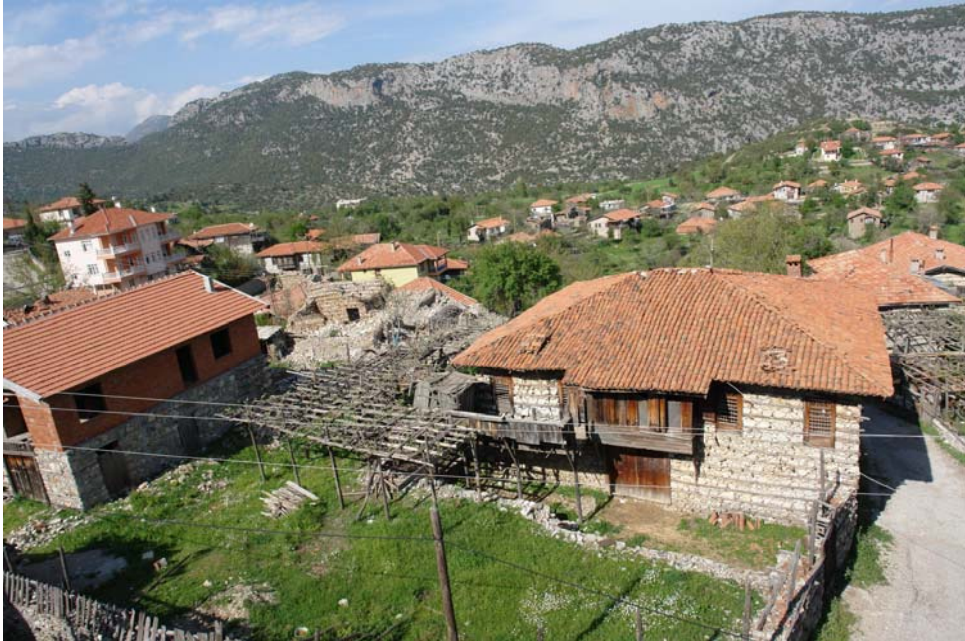
Şekil 4.45 Alaturka kiremit örtülü kıрма çatı
