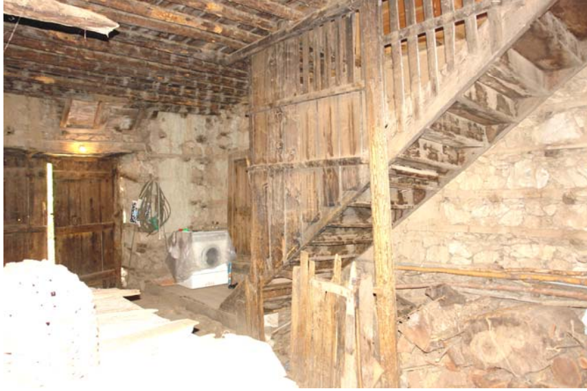
Şekil 5.3 Zemin kat merdiveni
