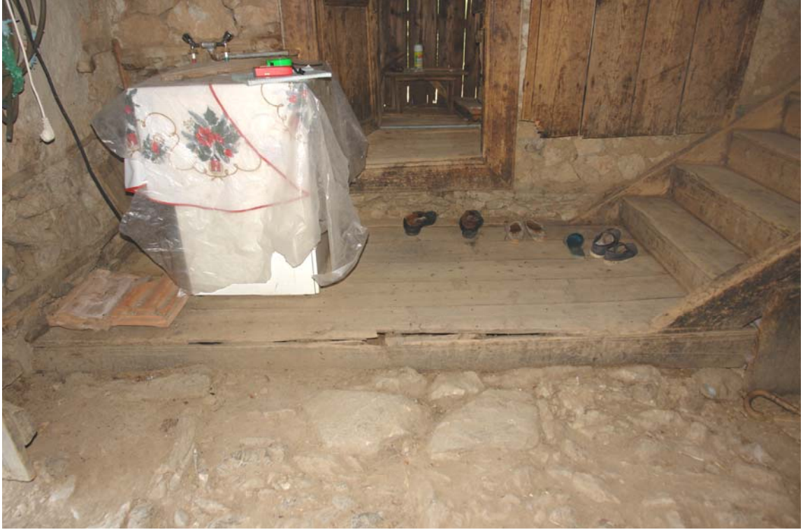
Şekil 4.15 Zemin kat döşemesinde taş kullanılması (taşlık)
