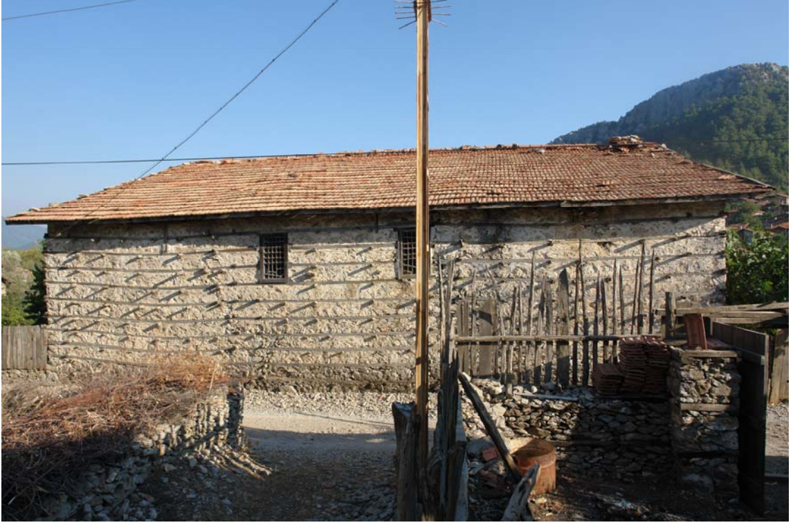
Şekil 5.49 Yapının batı cephesi
