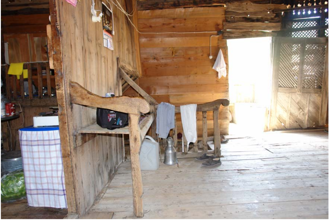
Şekil 4.21 Birinci kat ahşap kaplama tahtası
