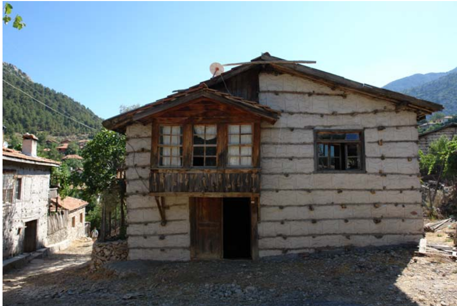
Şekil 4.1 Girişi sokaktan olan yapı
