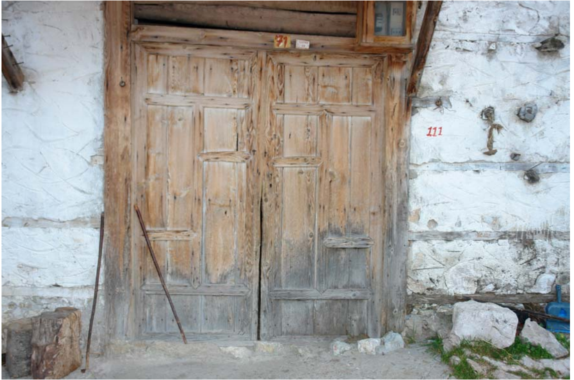
Şekil 4.50 T ablalı ahşap giriş kapısına bir örnek
