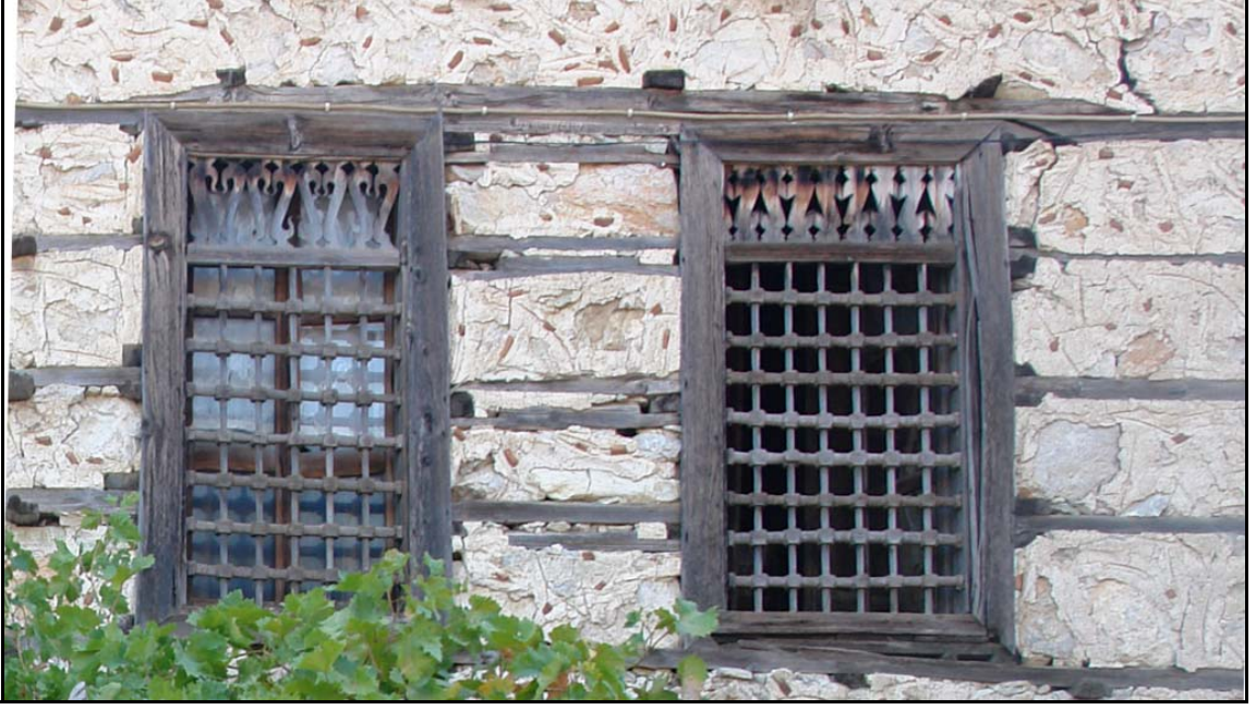
Şekil 4.60 Dıştan parmaklıklı, içten kepenkli pencere ve ahşap lento
