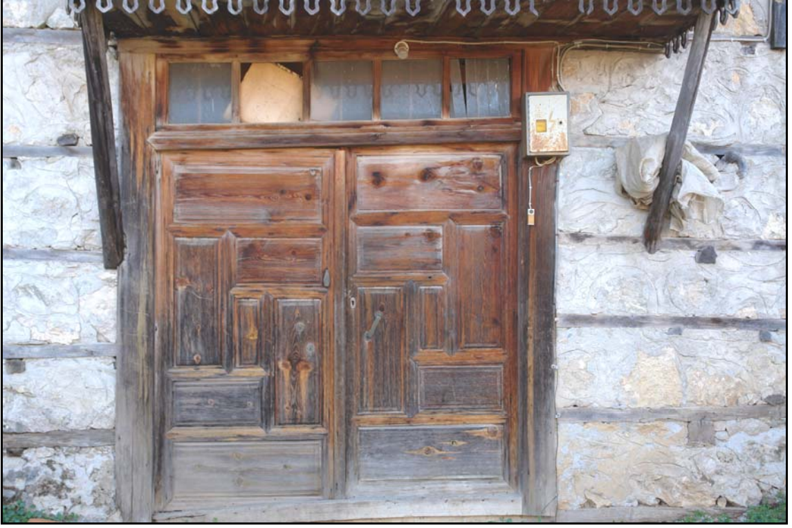
Şekil 4.49 Tablalı ahşap giriş kapısına bir örnek
