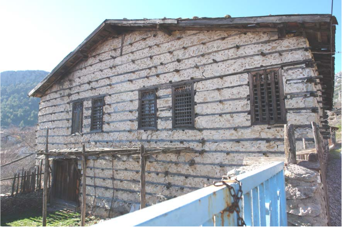
Şekil 4.13 Dış yüzeyde sakar sıva uygulaması
