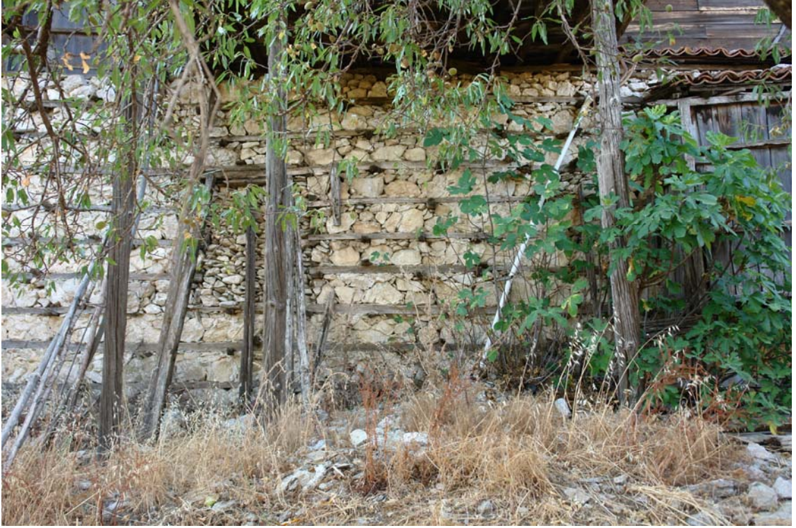
Şekil 5.46 Yapının doğu cephesinde zemin katta kapatılmış pencere
