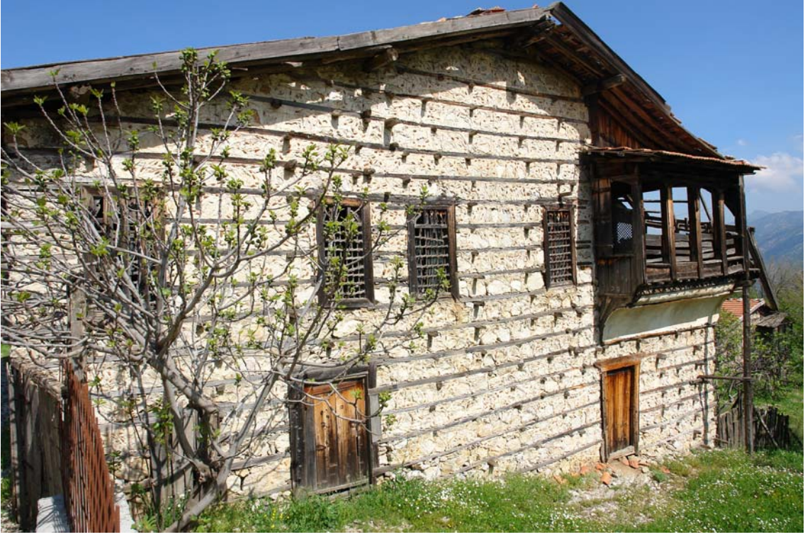
Şekil 5.41 Yapının güney cephesi
