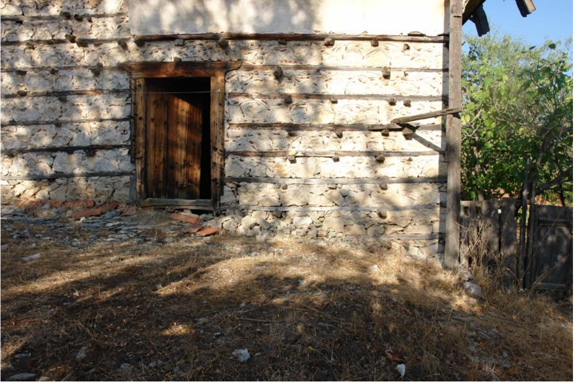
Şekil 5.43 Yapının güney cephesinden evöğüne giriş kapısı
