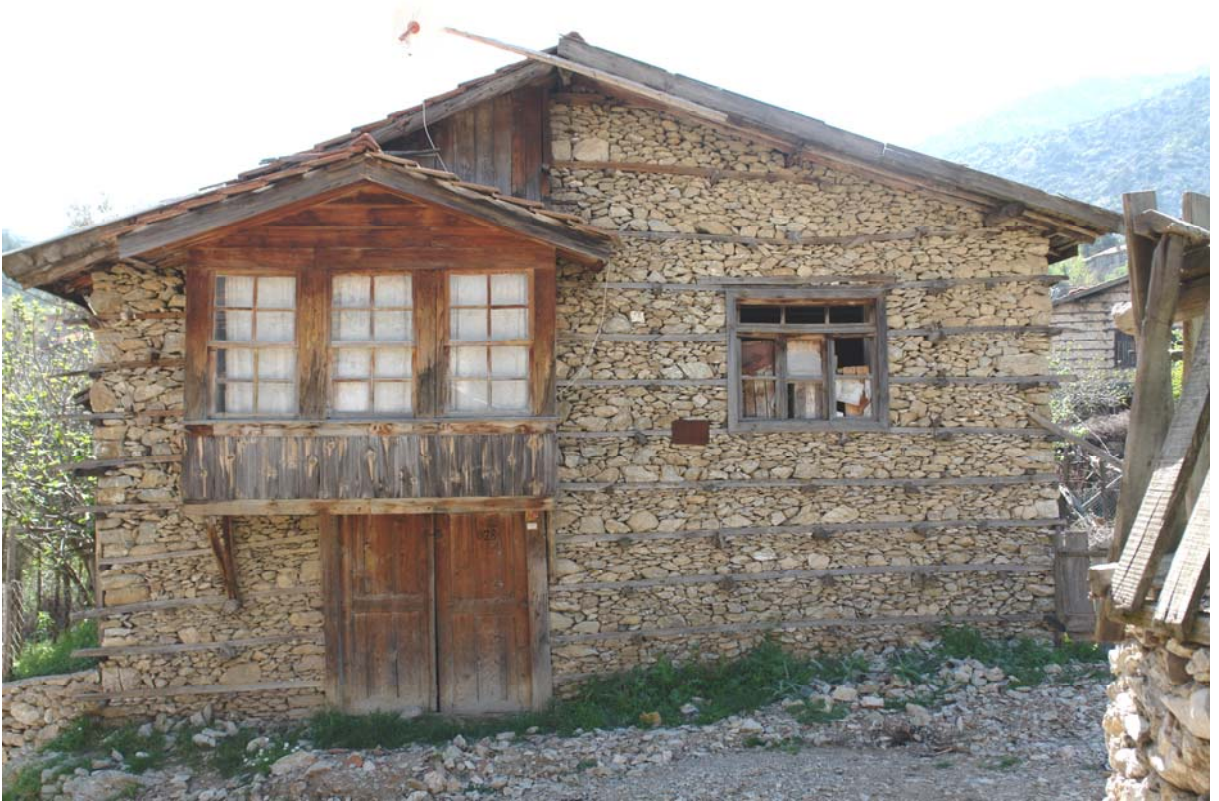
Şekil 4.47 Üçgen alınlıklı çıkmada çatı biçimlenişi
