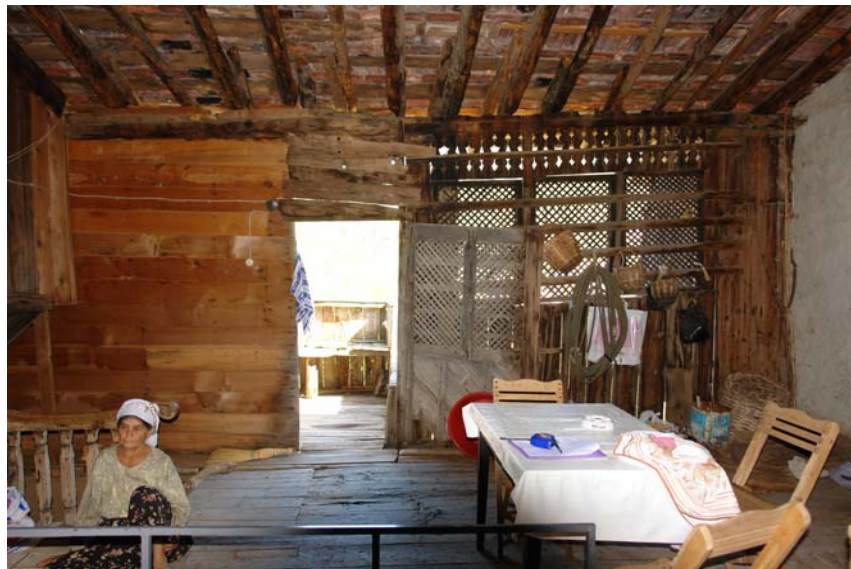
Şekil 5.11 Köşkten ayazlığa doğru bakış (101)
