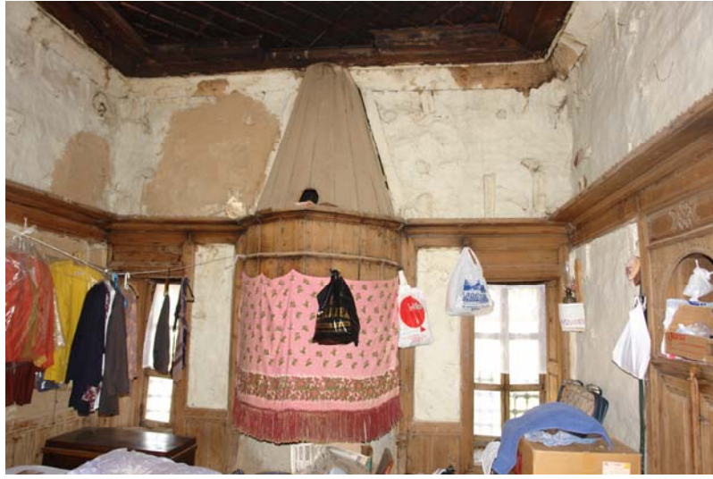
Şekil 5.20 104 no'lu odanın kuzey duvarındaki pencereler ve davlumbazlı ocak
