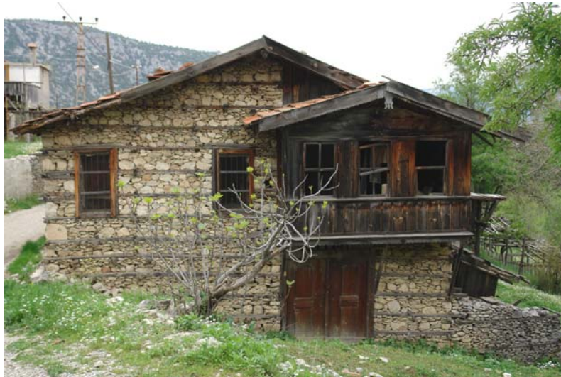
Şekil 4.31 Geleneksel Ürnlü evinde üçgen alınlıklı çıkma örneği
