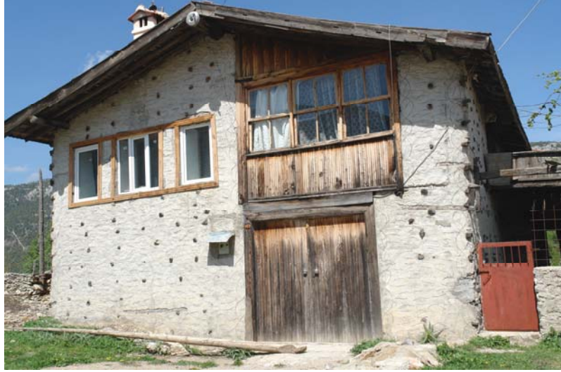
Şekil 4.30 Çıkma uygulanmayan cephede giriş üzeri ahşap kaplama örneği
