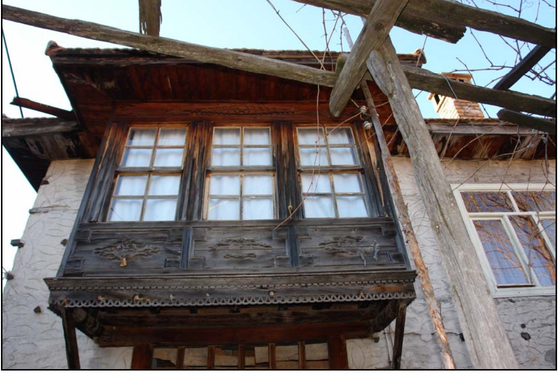
Şekil 4.63 Giyotin pencereli çıkma penceresi
