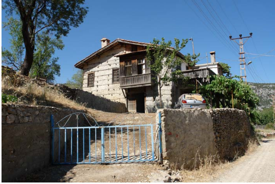
Şekil 4.2 Girişi bahçeden olan yapı
