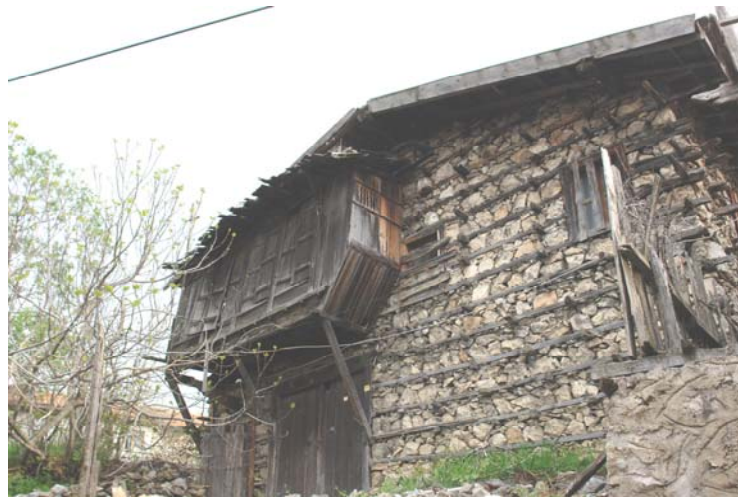
Şekil 4.29 Payandalarla desteklenen dıştan kepenkli çıkma örneği
