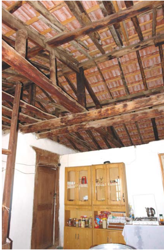
Şekil 4.42 Ahşap oturtma çatı
