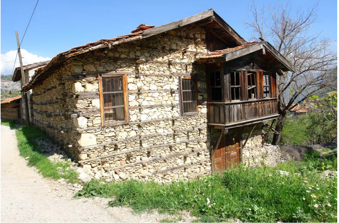
Şekil 4.12 Harçsız kuru duvar örneği
