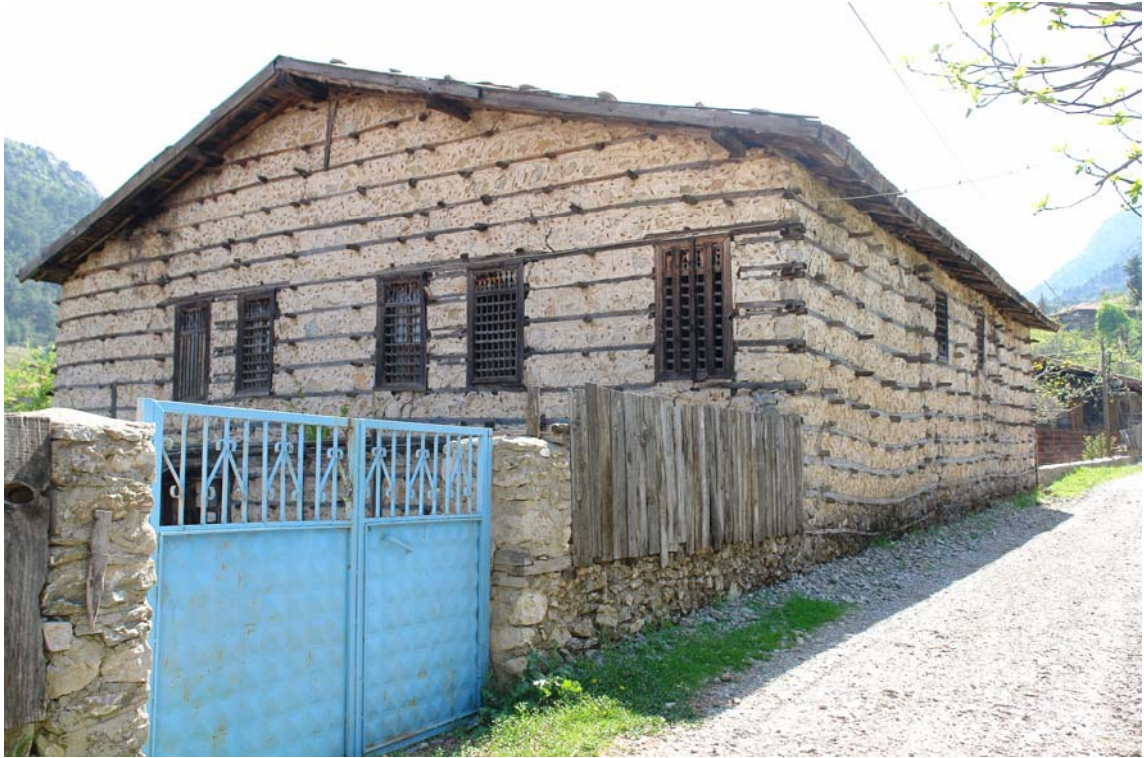
Şekil 5.39 Yapının kuzeyde bulunan giriş cephesi
