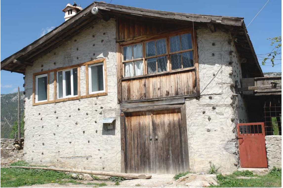
Şekil 4.14 Dış yüzeyi çimento harçlı sıva ile sıvanmış duvar örneği
