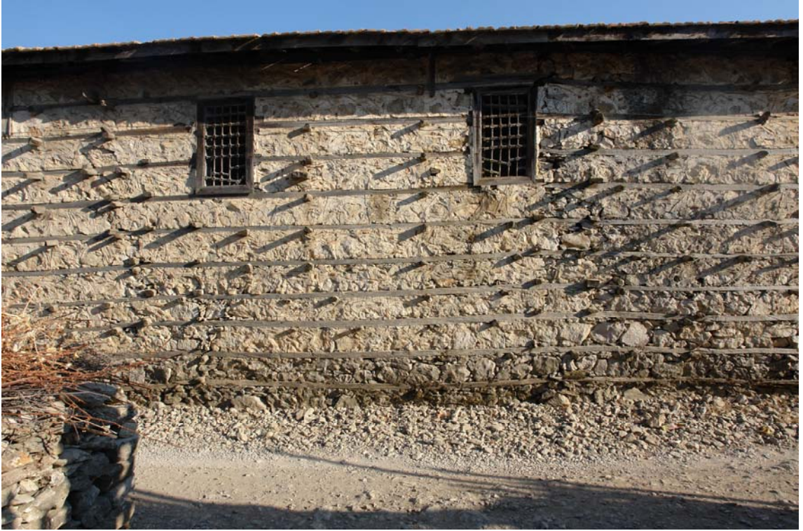
Şekil 5.50 Yapının batı cephesi
