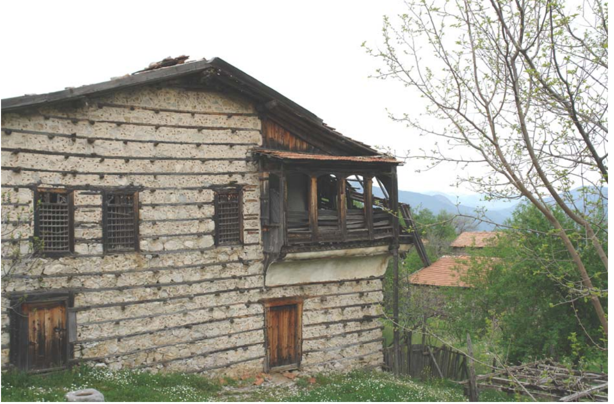
Şekil 4.35 Bağdadi çıtalar üzeri sıva tekniğiyle yapılmış eğrisel formlu köşe çıkma
