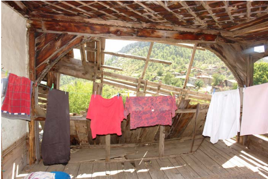
Şekil 5.34 108 no'lu şahnişinde bulunan ahşap kemer
