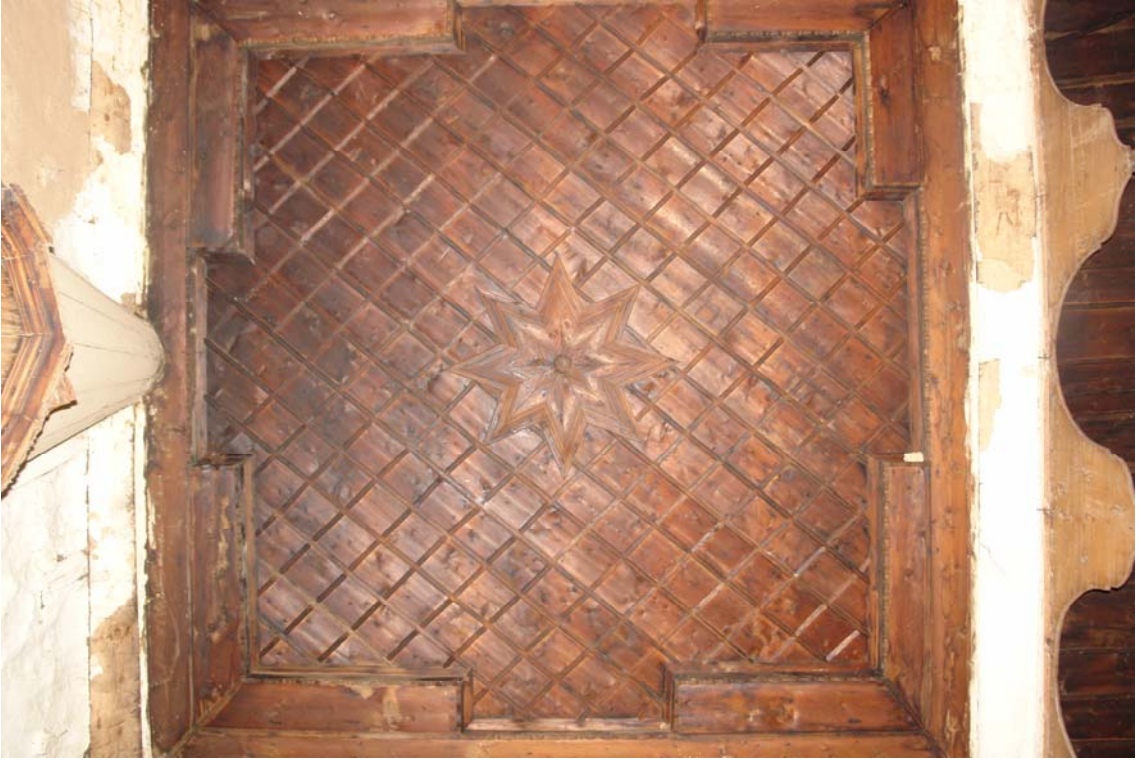
Şekil 5.23 104 no'lu odanın tavan kaplaması
