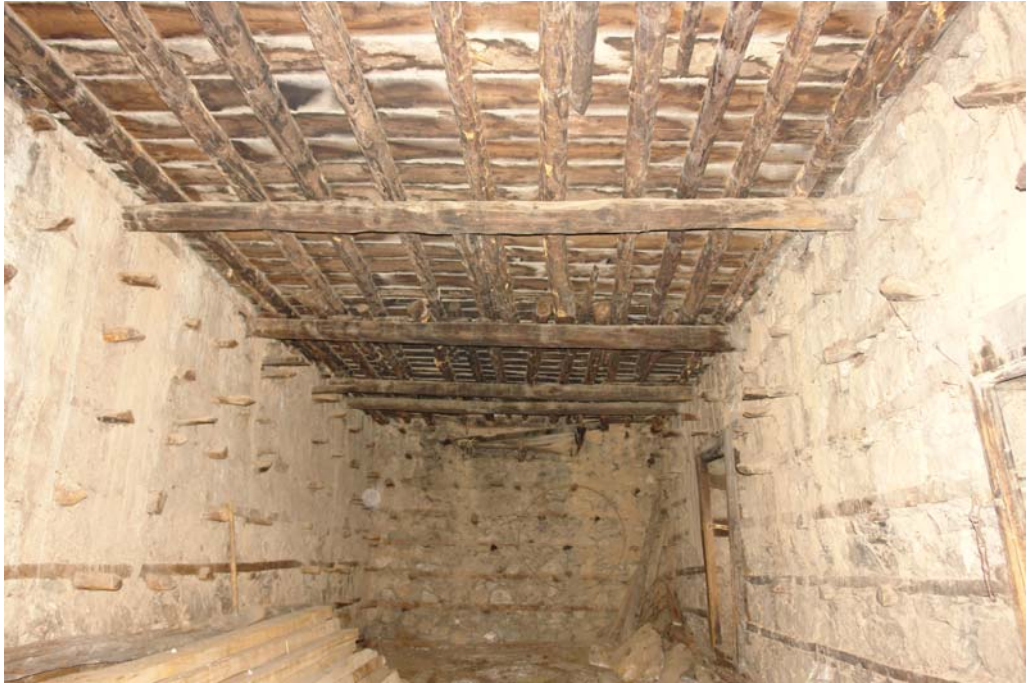
Şekil 4.17 Ahşap kiriş ve merteklerin yerleşimi
