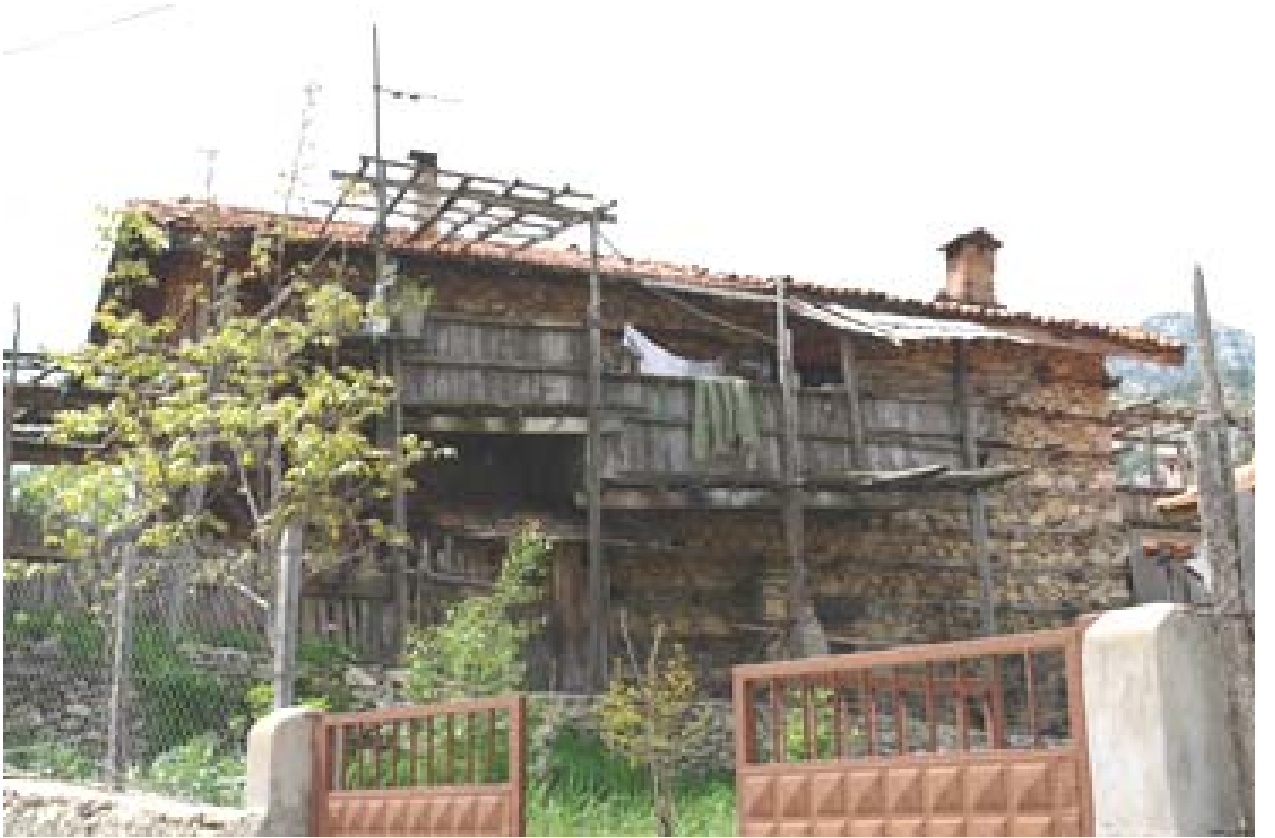
Şekil 4.39 Ahşap dikmelerle taşınan ayazlık örneği
