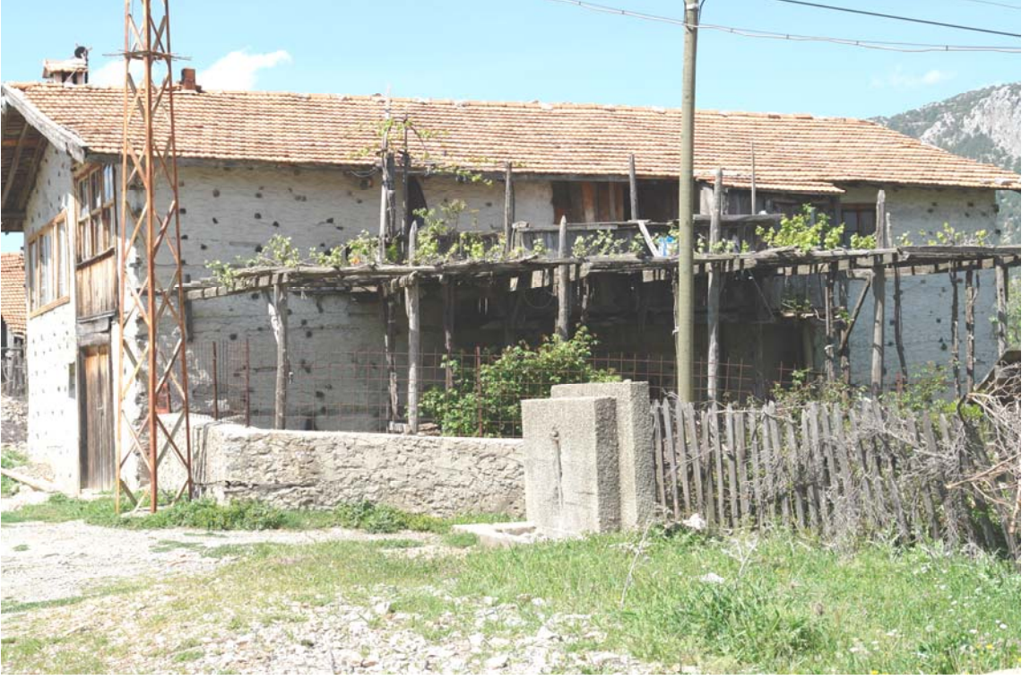
Şekil 4.40 Ahşap dikmelerle taşınan ayazlık örneği
