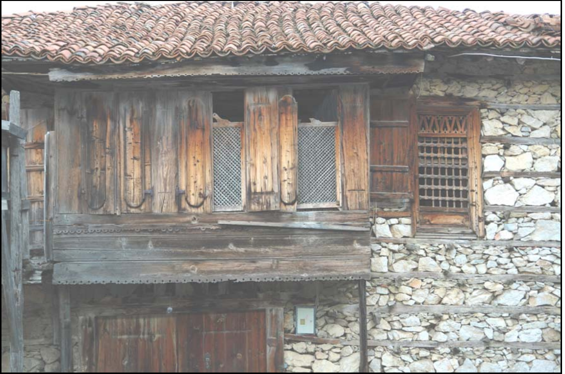
Şekil 4.61 Dıştan kepenkli, içten kafesli çıkma penceresi
