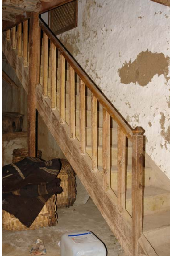
Şekil 4.23 Ürnlü evinde tek kollu, evöğünden sofaya çıkışı sağlayan merdiven
