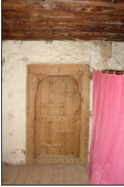
Şekil 4.54 Tablalı ahşap oda kapısına bir örnek (Bkz. Envanter No:50)
