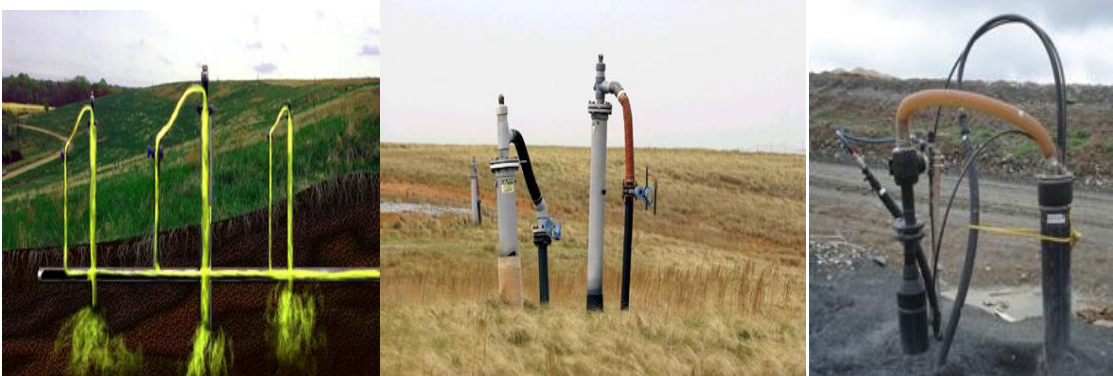
Şekil 4.6 Depolama alanı üzerindeki gaz kuyuları [52]
