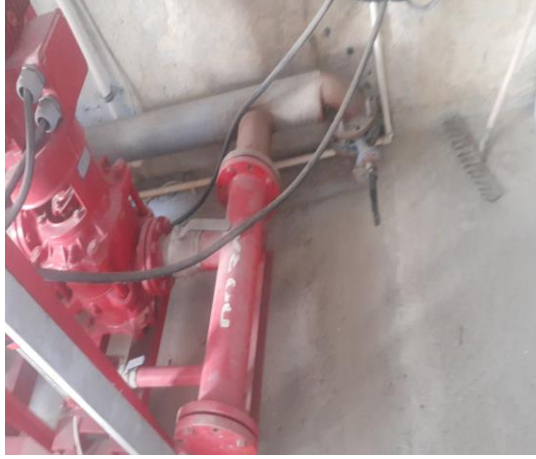
Şekil 3. 20 Depo çıkışı izlenemeyen vana kullanılması ve bağlantı hataları
