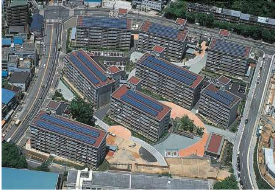
Şekil 5.8 Japonyadan örnek fotovoltaik sistem uygulaması
