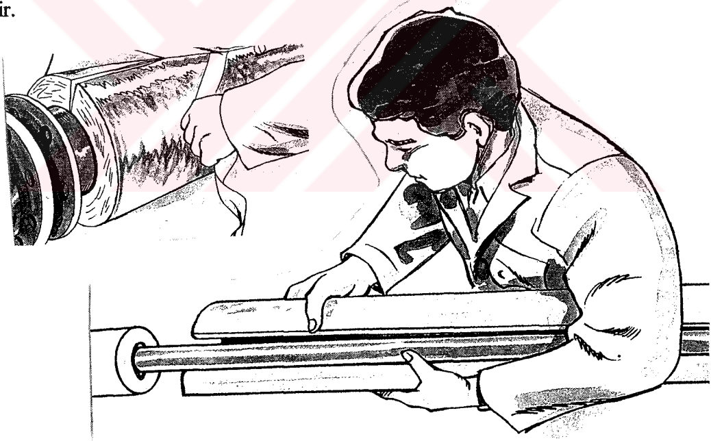
Şekil 4.46 Isıtma sisteminin borularının yalıtılması (Anon, 1996, ss. 3-16)
