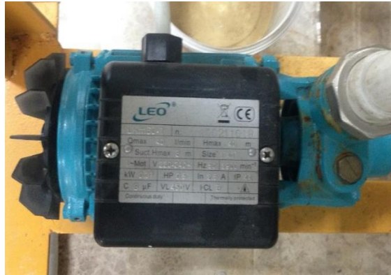
Şekil 3.7 Besleme suyu pompası
