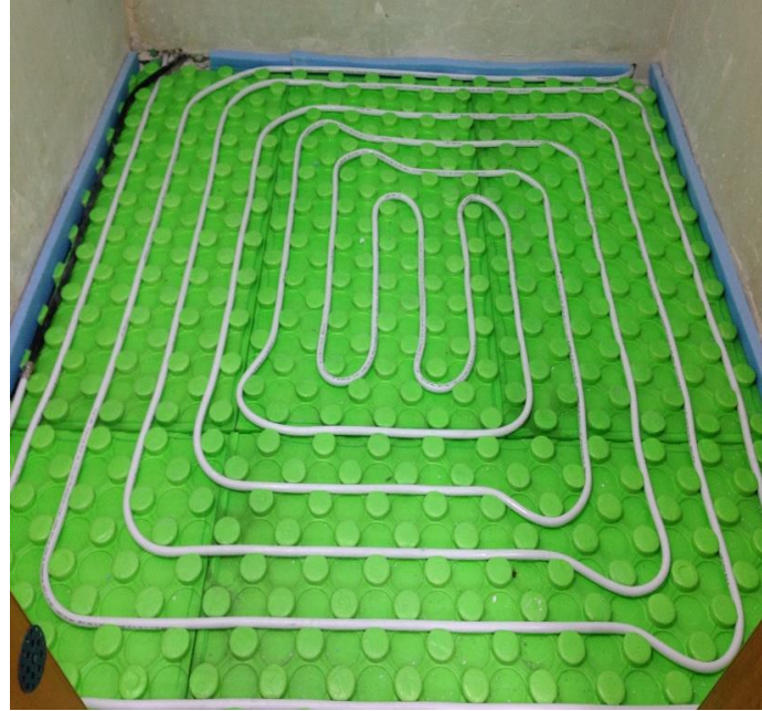
Şekil 3.17 Test odasının şap altı görünümü
