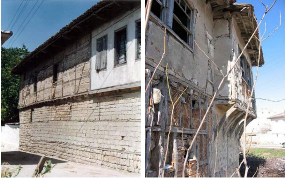
Şekil 4.1 Kapının konut bölümünden bir görünüş (İ. B. Dağgülü, M. Dağgülü, 2007)
