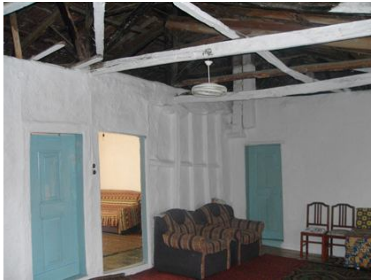
Şekil 4.3 Yusuf Korkmaz Evi, Akapınar, atı strüktürü görünüř olarak bırakılmıř
