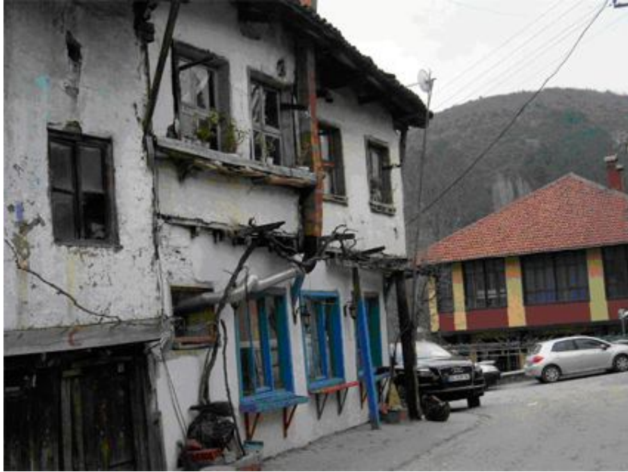
Şekil 3.4 Bursa, Misi Köy'de yola paralel zemin kat duvarı üzerine yapılmış üçgen çıkma.
