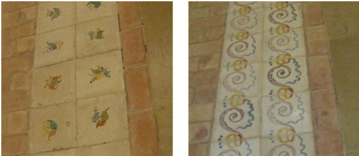
Şekil 3.11 19. yy'dan kalma yer döşemelerinin, restorasyon sonrası görünümü.
