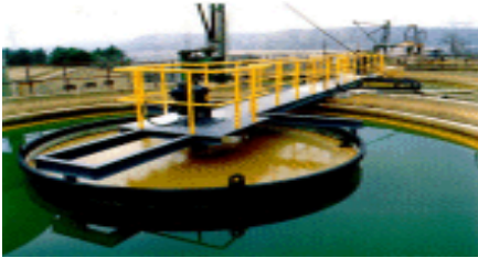
Şekil 2.3 Çökeltme havuzu
