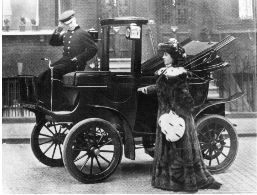
Şekil 2.1 1901 yılında New York'ta geliştirilen ve elektrik motoru ile tahrik edilen bir taksinin görünümü (Larminie ve Lowry, 2003)
