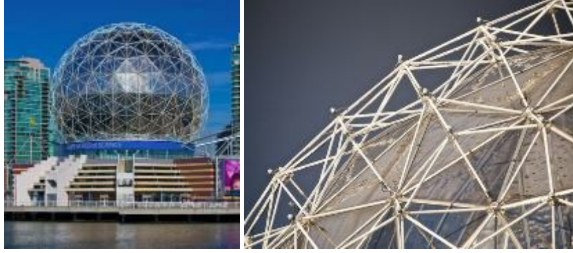
Şekil 3.140 Science World Dome, Vancouver, Kanada, (1977) [11], [235]
