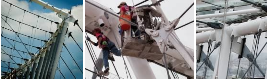
Şekil 4.62 Fuaye bölümü kablolu sistem inşaat aşamaları [349]
