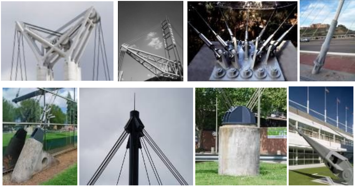
Şekil 3.186 Kablolu sistem bağlantı detayları [11], [140], [283], [284], [285], [286]
