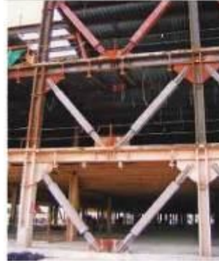
Şekil 3.105 Betonarme perde ve çelik çapraz [192], [193]
