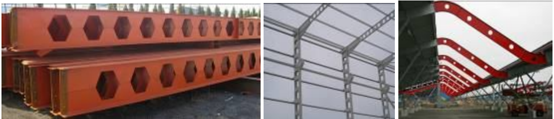
Şekil 3.6 Gövdesi boşluklu kiriş ve kiriş-mesnet detayları [29], [32], [33]
