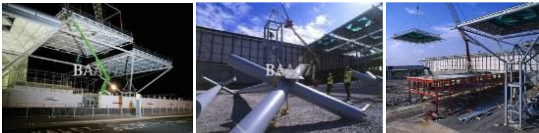
Taşıyıcı sistem elemanları parçalar halinde fabrikada üretilmiş ve yerinde montajı yapılmıştır. Ön üretimin tercih edilmesi, hava şartlarından bağımsız olarak, üretim ve montajın eş zamanlı devam etmesini sağlamıştır (Şekil 4.36).
