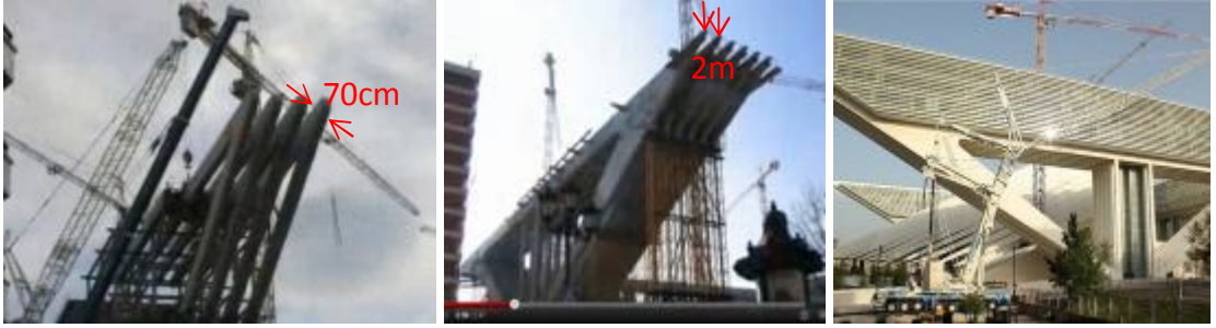
Şekil 4.42 V Kolon birimleri [154]
