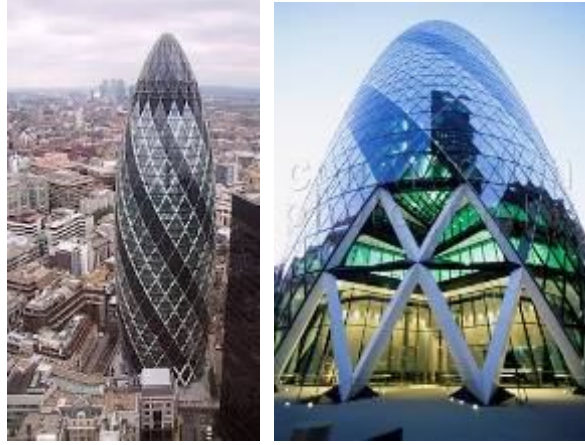
Şekil 4.49 Swiss Re Tower [17], [286]
