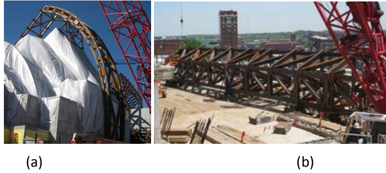
Şekil 4.59 Taşıyıcı sistem birimleri (a) Kemer birimi (b) Tavan birimi [347]
