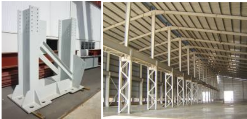
Şekil 3.44 Kafes gövdeli kolon örneği ve mesnet detayı [99], [100]
