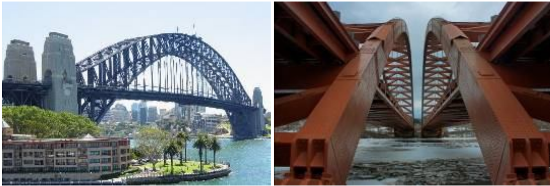
Şekil 3.63 Harbour Bridge, Sydney, Avustralya (1932) ve Thaddeus Kosciuszko Bridge, New York, A.B.D (1959) [11], [131]
