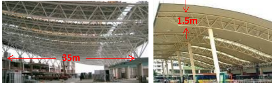
Şekil 3.19 Esenboğa havalimanı, Ankara (2006) ve Uzay kafes kiriş örneği [52], [53]
