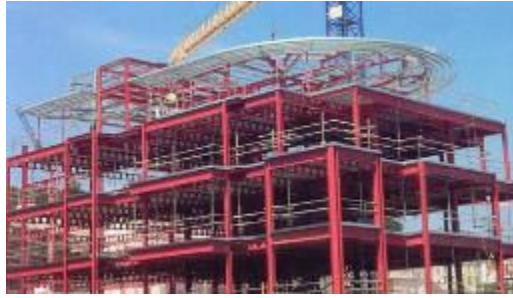
Şekil 3.106 İki doğrultuda çalışan çerçeve sistem örnekleri [138], [194]
