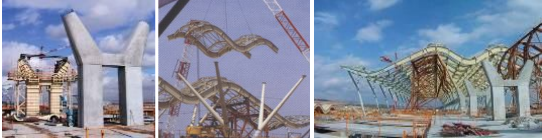
Şekil 4.4 Taşıyıcı sistem uygulama aşamaları [107]
