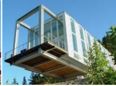
Şekil 3.106 İki doğrultuda çalışan çerçeve sistem örnekleri [138], [194]
