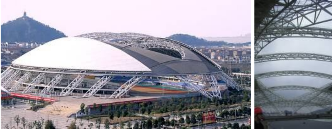
Şekil 3.72 Nantong Sports Centre, Nantong, Çin (2006) [141], [142]
