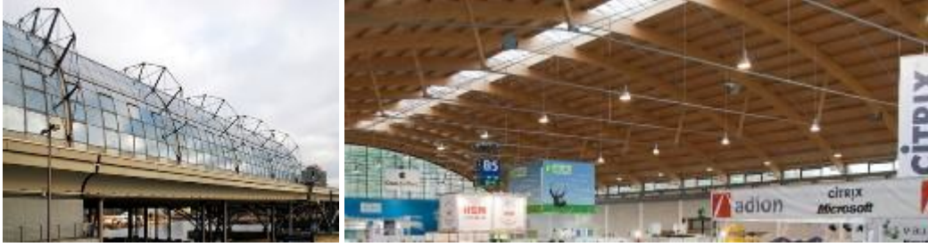
Şekil 3.195 Tek eğrilikli ve çift tabakalı kablo kirişli çatı sistem örnekleri [11], [118]
