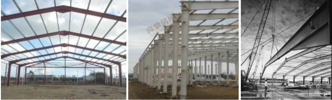
Şekil 3.83 Mahya ve köşe rijit nokta detayları [1], [164], [165]
