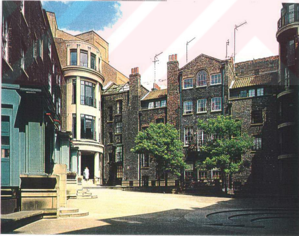
Resim 5.3.5.e: Avlunun genel bir görüntüsü ve yeni yapılan köşe binalar.
