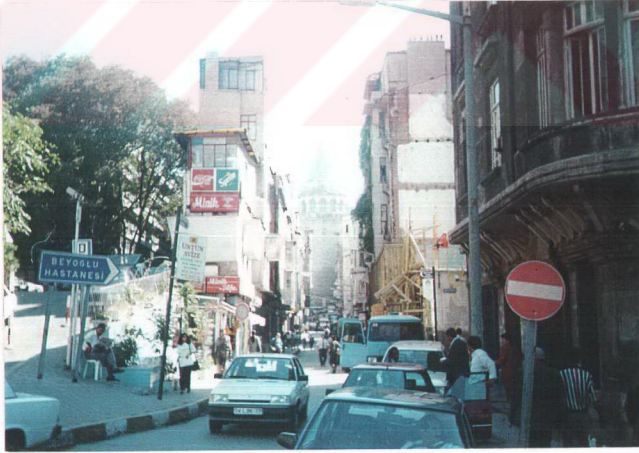
Resim 6.5.f: Büyük Hendek Sokağı sağ başında yeni yapılmakta olan inşaat.
