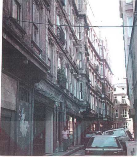
Resim 6.4.1.3.a: Yapıların zemin katları dükkan, üst katları konut olarak kullanılmaktadır.
