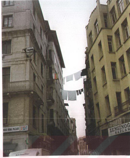
Resim 6.5.e: Sağda Küçük Hendek Sokağı köşesinde daha önce varolan apartmanlardan biri.
