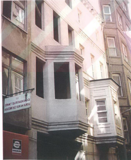
Resim 6.5.i: Kız Kuran Kursu binası yanındaki yapının yenilenmesinde yanındaki eski binaya uyum sağlama çabası görülmektedir.
