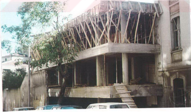
Resim 6.5.c: Horoz sokakından ek inşaatın görünümü.
