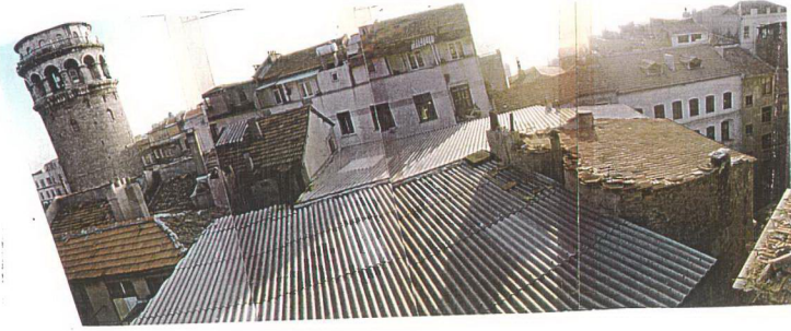
Resim 6.4.1.3.c: Bir çatı grubunun görünümü
