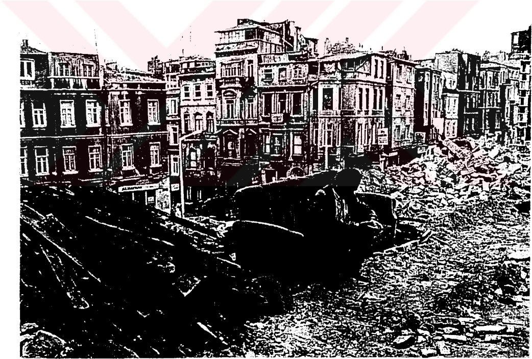
Resim 5.2.2.1: Tarlabası Bulvarının açılması ile tarihi kent dokusu tahrip edilmiştir."Büyük çoğunluğunu İstanbul'daki 'levanten' kültürünün en zengin sivil mimarlık örneklerinin oluşturduğu 386 'Pera' binasının tümüyle hukuk dışı yöntemlerle yıkıldığı bu operasyon, yasal bir imar planı olmadığından kamulaştırma yerine baskı uygulayarak satın alma yöntemiyle gerçekleştirilmiştir." (Ekinci O.,1994).
