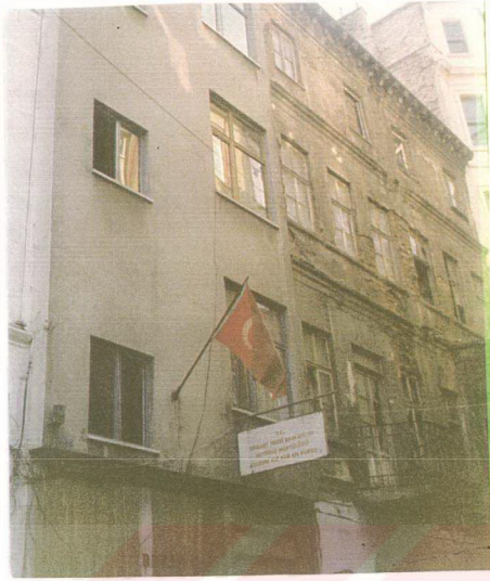
Resim 6.5.1: Küçük Hendek Sokağında hiçbir özelliği olmayan Kuledibi Kız Kuran Kursu binası ve yanında bakımsız eski bina.
