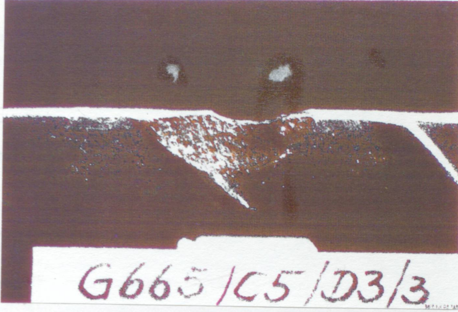
Fotoğraf 8.6 Klorür nedeniyle oluşan korozyon çukuru [22]
