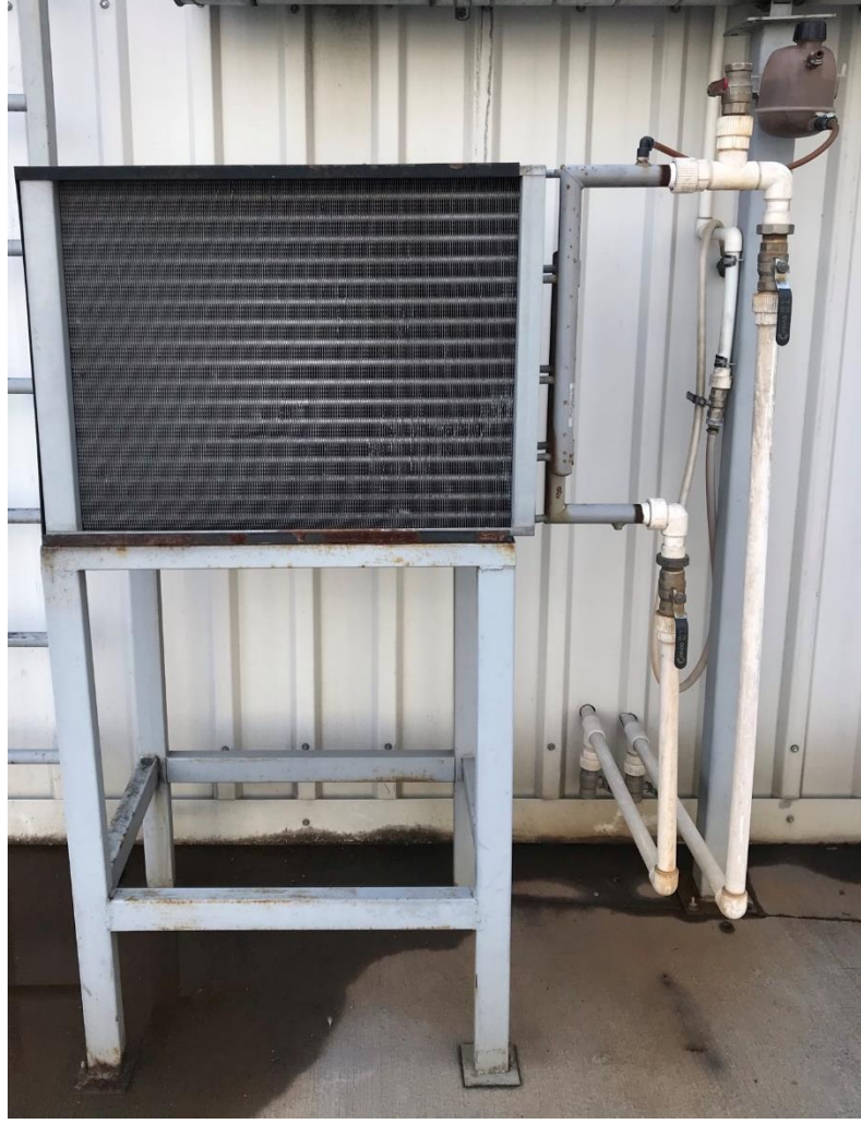
Şekil 3.13 Motorun soğutma sisteminin fotoğrafı
