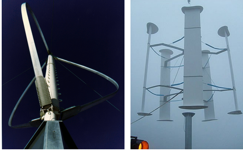
Şekil 2. 2 Darrieus tipi dikey eksenli rüzgar türbinleri
