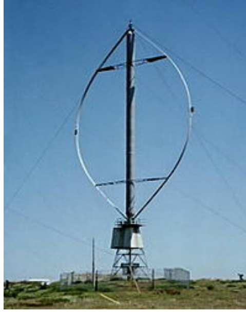
Şekil 4. 4 Düşey eksenli rüzgar türbini
