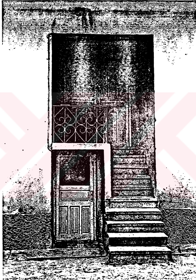
79 ADA 2 PARSEL GİRİŞ KAPISI
