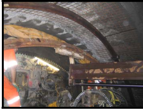
Şekil 2.19 San Gottardo tüneli (www.tat-ti.ch)
