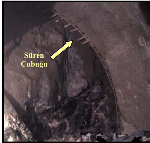
Şekil 2.7 Tünelde süren uygulamasından bir görünüm
