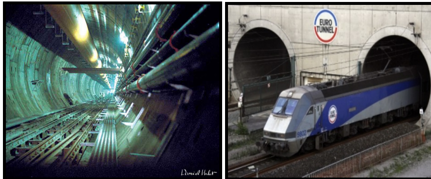
Şekil 2.17 Manş tüneline görünüm (http://tempsreel.nouvelobs.com)
