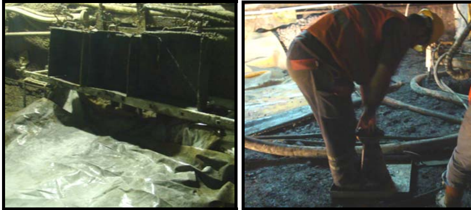
Şekil 4.4 Uygulama yerindeki paneller ve çökme ölçümünden bir görünüm.
