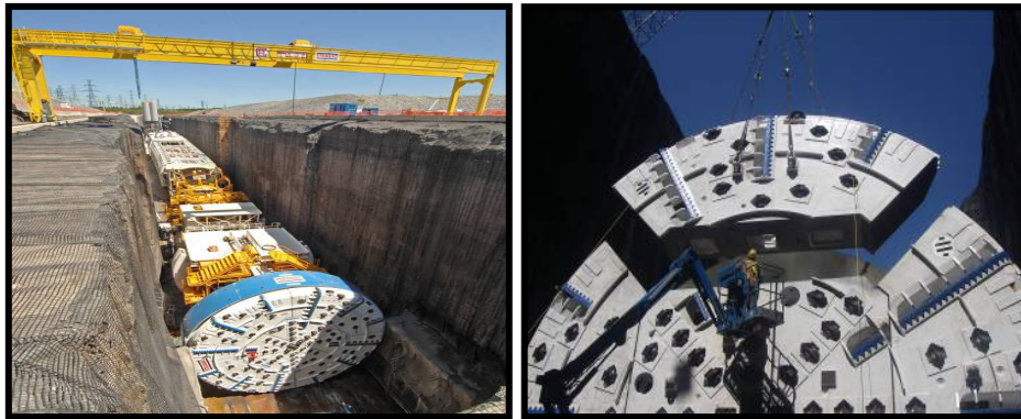
Şekil 2.40 Niagara projesinde kullanılan TBM'den görünüm (www.infobatt.com)
