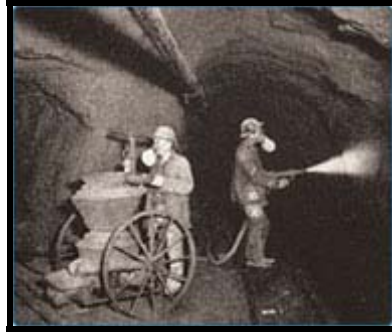
Şekil 3.3 Tabanca sistemi kullanılarak püskürtme betonun yüzeye uygulanması ( www.allentownshotcrete.com )
