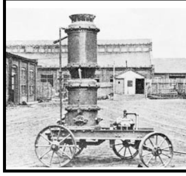
Şekil 3.2 Akeley'in 1907'de geliştirdiği püskürtme beton aleti ( www.shotcrete.org )
