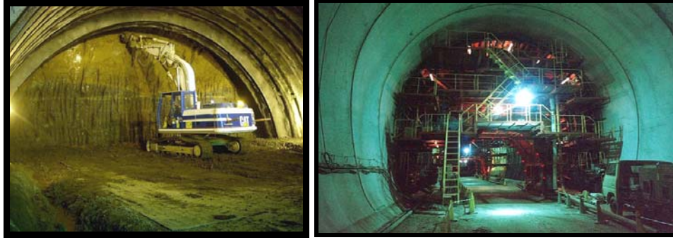
Şekil 2.29 NATM ile inşa edilen tünelden görünüm (www.marmaray.com.tr)
