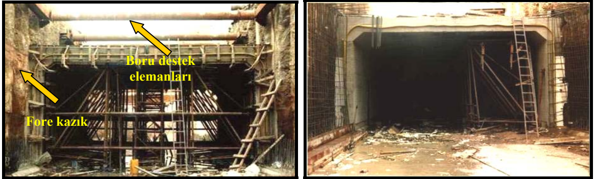
Şekil 2.50 Aç-kapa yöntemi ile inşa edilen tünel
