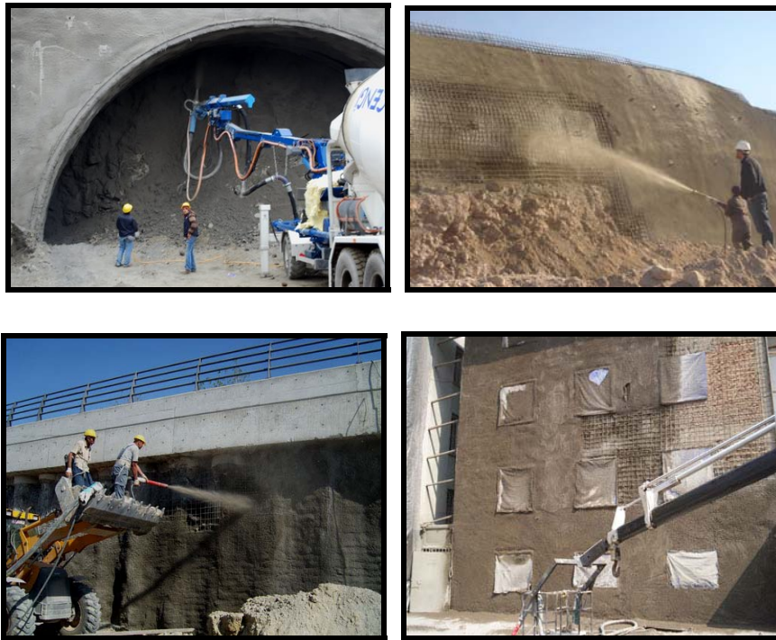
Şekil 3.1 a) Tünel kazı destekleme b) Şev stabilitesi c) Kazı-iksa sistemi d) Bina güçlendirme uygulamalarında püskürtme beton (www.admixtures.org)
