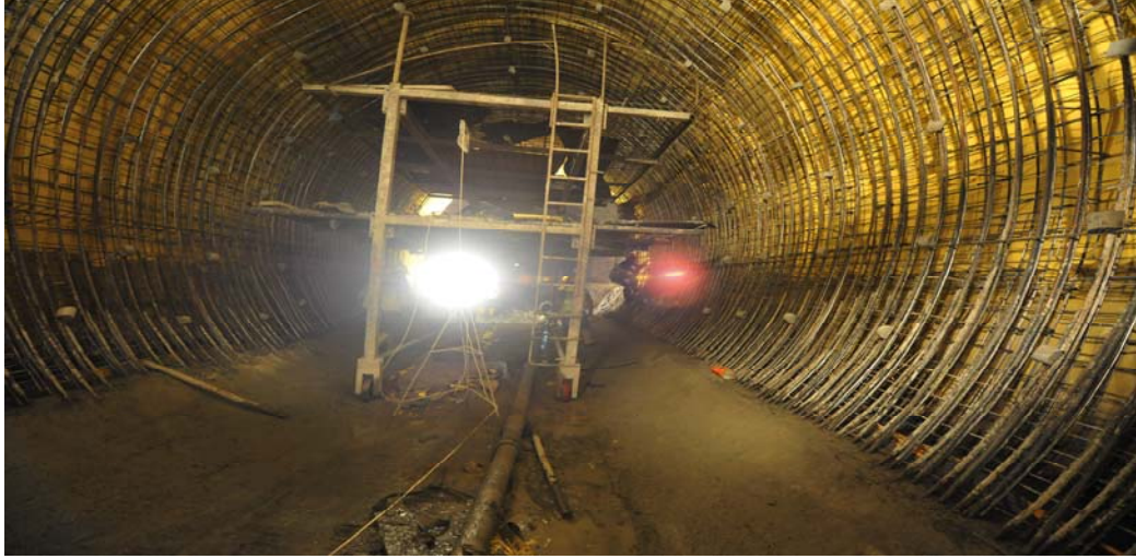
İç kaplama kısmına yerleştirilen donatıların bağlantılarının yapılması
