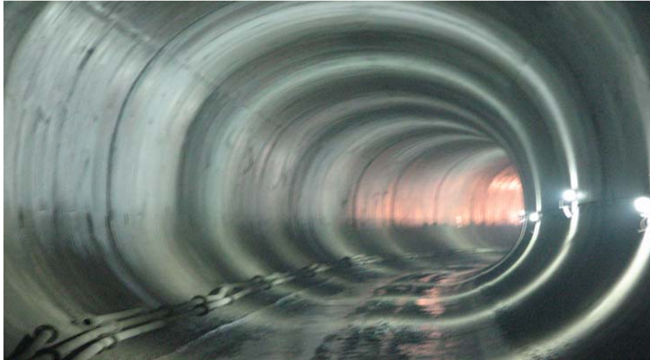
Donatıların yerleştirilmesinin ardından çelik gövdeden hazırlanmış olan üst yarı (kemer) hidrolik kalıbı çekilerek betonun dökülmesi ile bir anoluk kısmın nihai kaplama betonu imalatı tamamlanmış olur.
