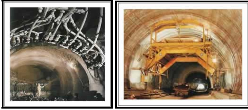
Şekil 2.30 Frankfurt Metrosu, NATM ile yapım aşamalarından görünüm (http://aic-anthes.com)
