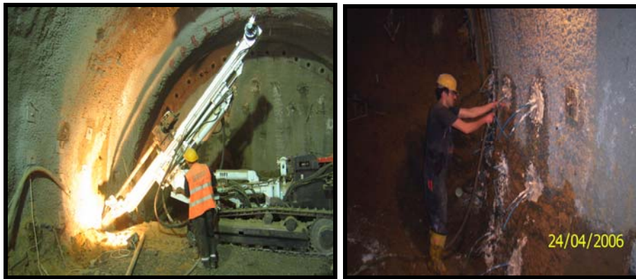
Şekil 0.6 Yan zemin çivisi delgisinin yapılması ve boru ucunun alçı ile sıvanarak çimento şerbeti enjeksiyonu yapılması
