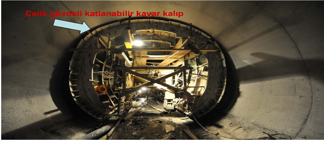
Donatıların yerleştirilmesinin ardından çelik gövdeden hazırlanmış olan üst yarı (kemer) hidrolik kalıbı çekilerek betonun dökülmesi ile bir anoluk kısmın nihai kaplama betonu imalatı tamamlanmış olur.
