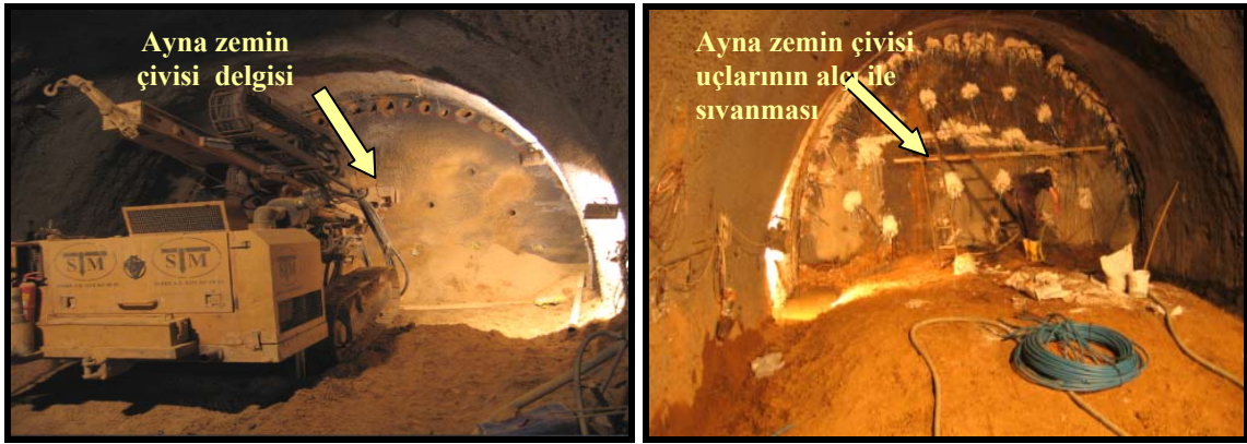
Şekil 0.5 Ayna zemin çivisi delgisinin yapılması ve boru ucunun alçı ile sıvanarak çimento şerbeti enjeksiyonu yapılması (H.İ.Ayış arşivinden)
