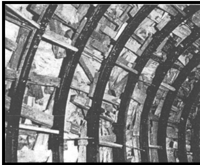
Şekil 2.2 Demir destek elemanları ile tünel desteklenmesi (Fukushima, 1975)
