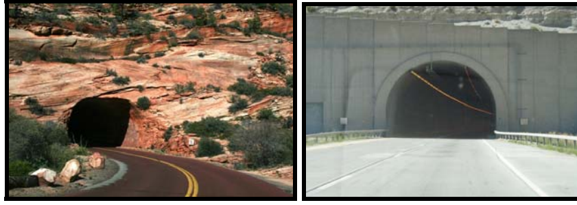
Şekil 2.16 Utah tüneline görünüm (www.pbbase.com)
