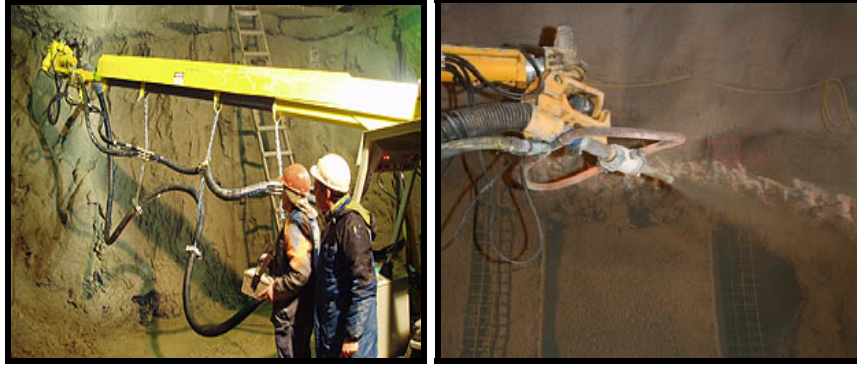
Şekil 3.7 Püskürtme betonun robot makinesiyle uygulanması (www.putzmeister.com.tr)
