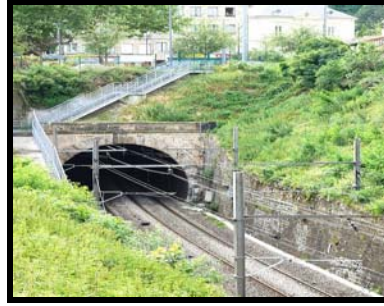
Şekil 2.8 Terre Noire hattındaki tünel görünümü ( http://en.structurae.de )
