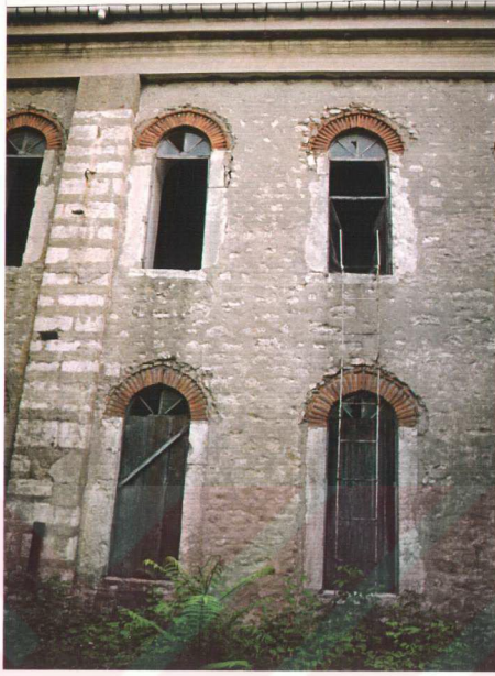
Resim : 29 - Kışla binası, kullanılmayan bölümlerden görünüşler.
