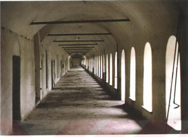
Resim : 41 - Kışla binası, alt kat koridora hamam çıkışından bakış.
