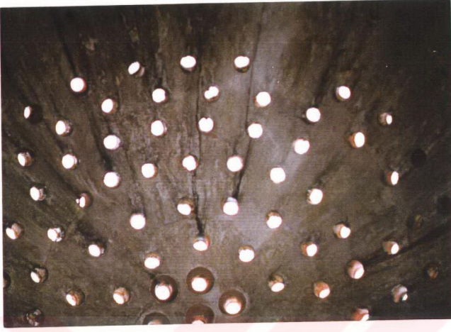
Resim : 48 - Kışla hamamı sıcaklık kısmı kubbe içi görünüşü.
