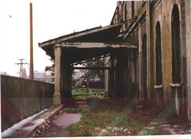
Resim : 52 - Askeri Fırın, kuzeydoğu cephesinden ana girişe bakış.
