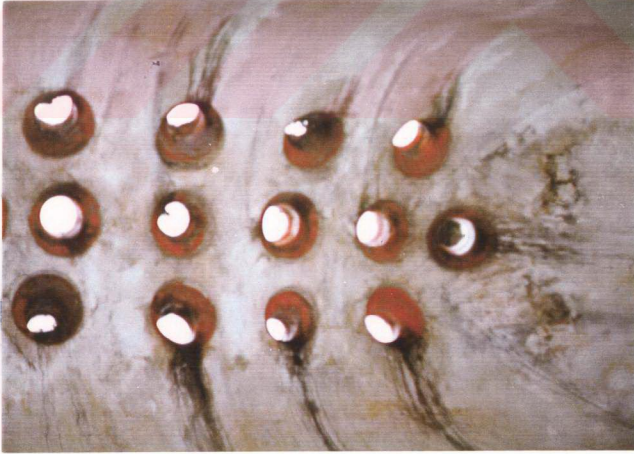
Resim : 49 - Kışla hamamı içinden tonoz görünüşü.
