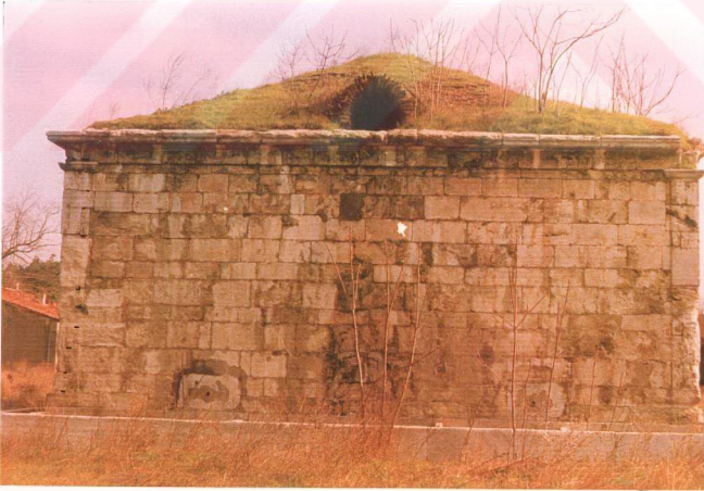
Resim : 63 - Su Deposu, kuzeydoğu görünüşü.
