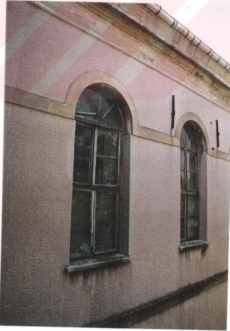
Resim : 34- Kışla binası, iç avludan metal kenet görünüşü.
