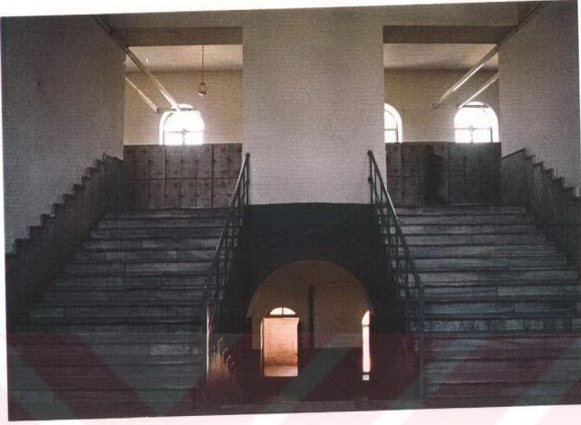
Resim : 36 - Kışla binası, merdiven detayı (orta sahanlıktan bakış)
