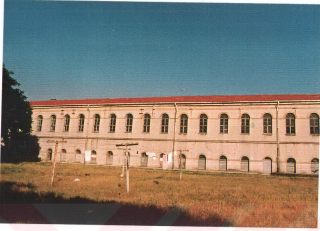
Resim : 29 - Kışla binası, iç avlu kullanılmayan bölümlerden görünüşler.
