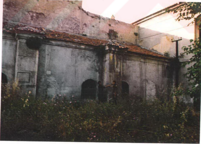
Resim : 45 - Kışla hamamı görünüşleri.
