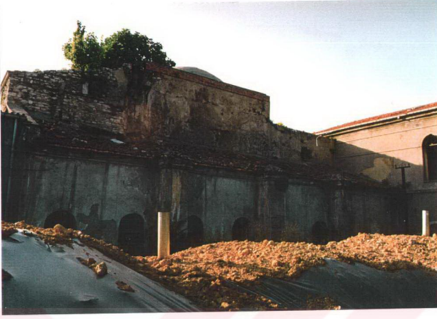
Resim : 41 - Kışla hamamı, görünüşleri.
