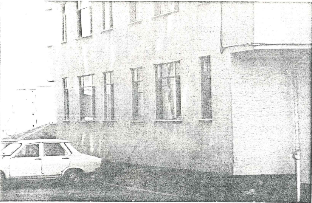
D-Blok zemin kat daireleri. Balkonların tamamen kapatılmış hali.
