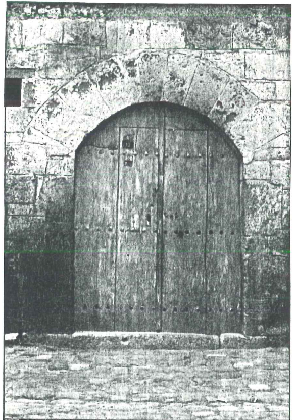
Resim 16. Kemerli avlu kapısı
