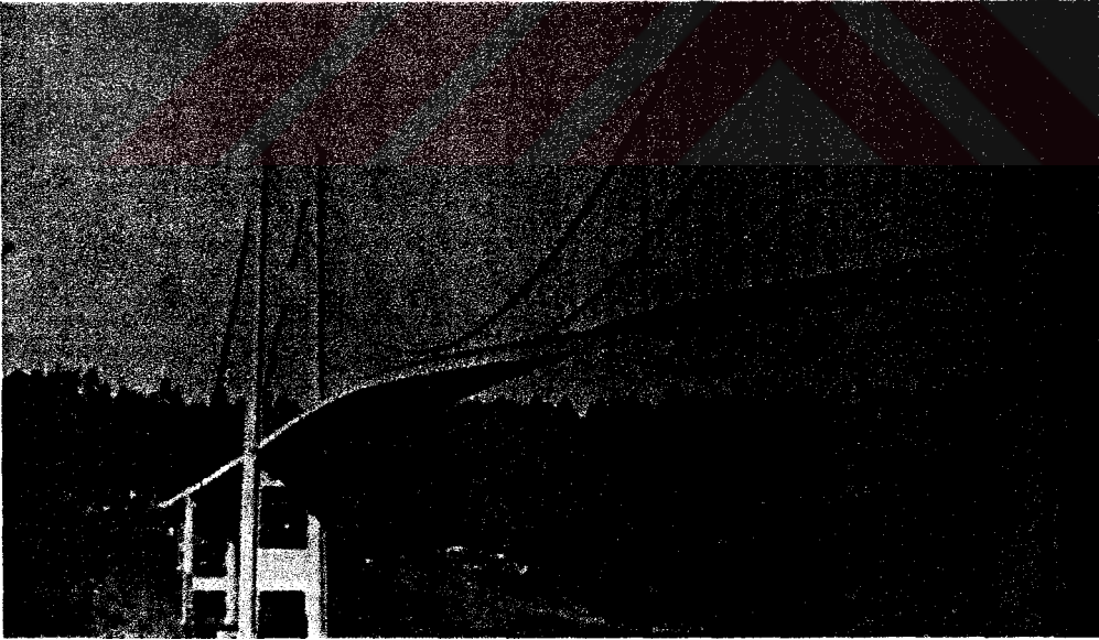
Şekil 3.1 Tacoma Narrow Köprüsü'nün rüzgar kuvveti altında rezonans hali
