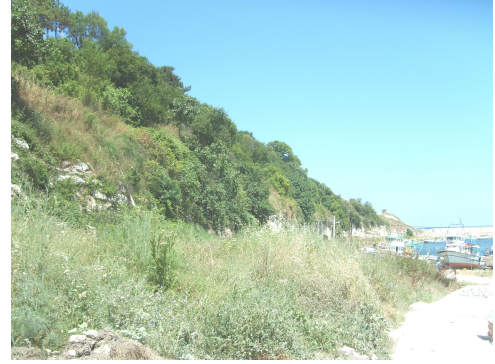
Resim 3.3 Güney Cephesi Surları
