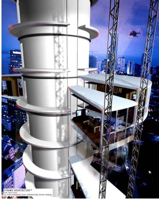
Şekil 4.29. Dynamic Tower prefabrik inşa sistemi (24)
