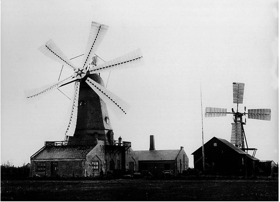
Şekil 3.4. Paul La Cour'un 1897'de Danimarka'da Askov Halk Okulu'nda ki iki deney türbini (3)
