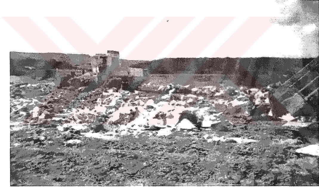
Şekil 2.5 Dökülen çöpün kompaktörlerle alana yayılıp, sıkıştırılması
