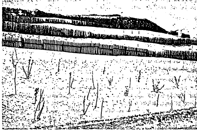
Resim 13: Rüzgâr Erozyonuna Karşı Tesis Edilmiş Tahta Perdelerin Arazide Görünüşü. (Kay. No: 10, Gen.Yay.No: 157)
