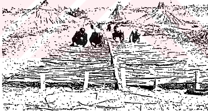
Resim - 14 : Rüzgâr Erozyonuna Karşı Kamış Perdelerin Örülmesi
