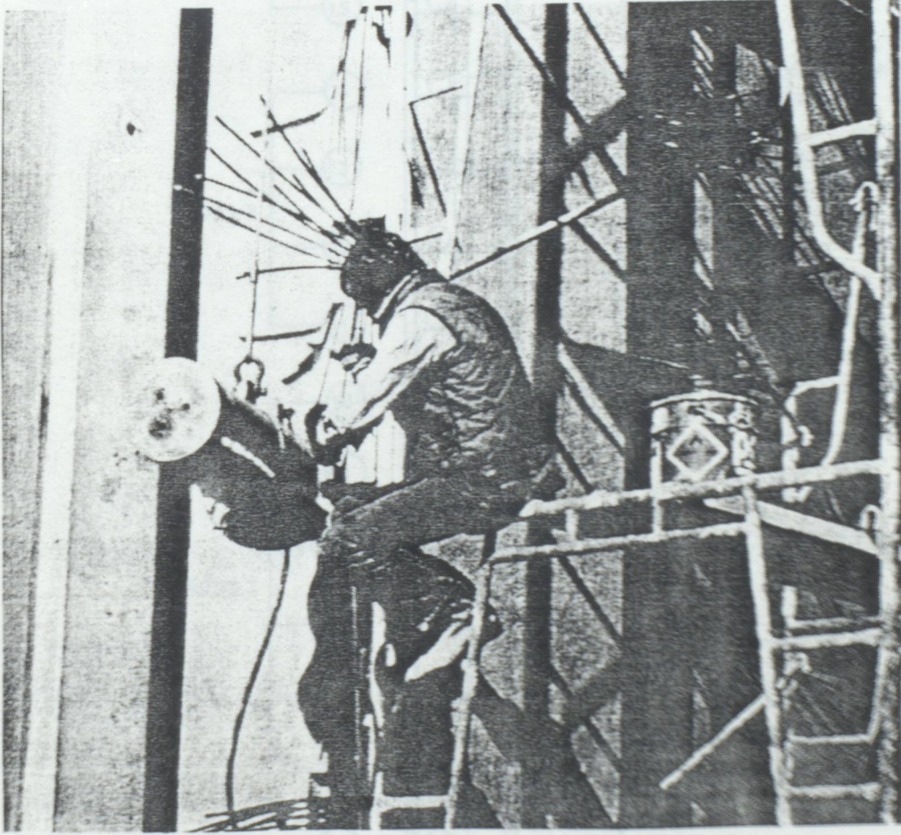
Resim 10 Tendonların krika ile gerilmesi.
