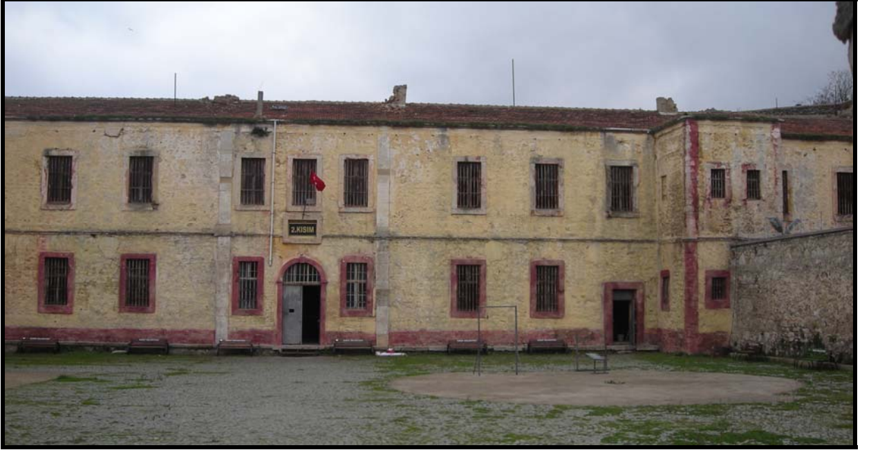
Şekil 3.21 Sinop Cezaevi 2. Kısımdan görünüş
