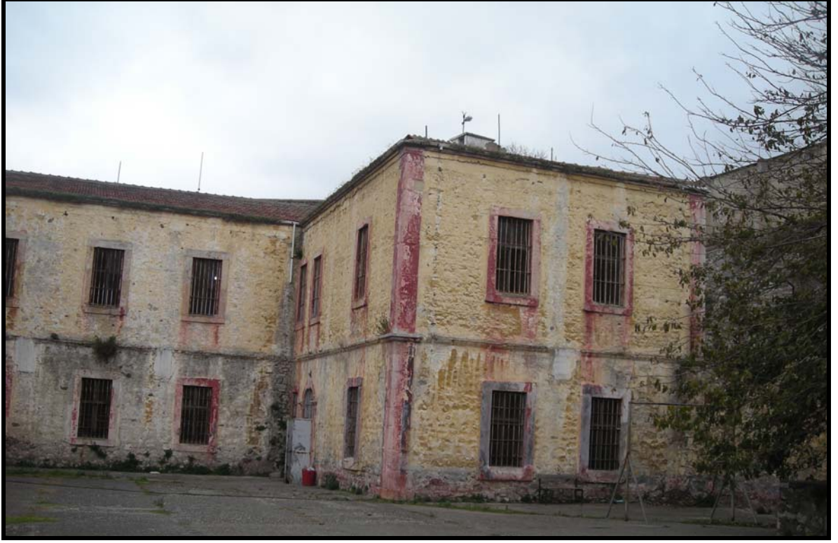
Şekil 4.43 Sinop Cezaevi 1. Kısımdan görünüş
