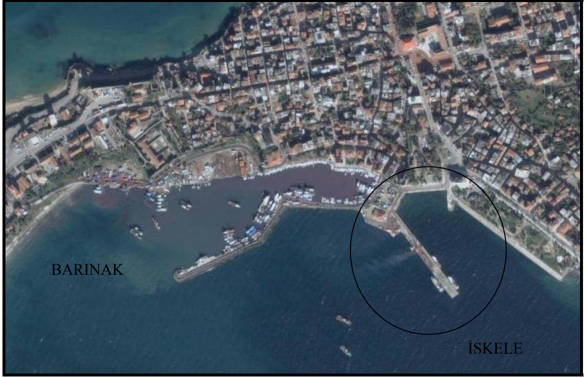
Şekil 4.15 Sinop Merkez Balıkçı Barınağı ve İskelesi (Limanı) uydur görüntüsü (Google Earth)
