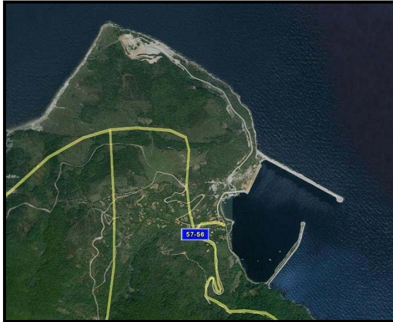
Şekil 4.12 Çaylıoğlu (Ayancık) Balıkçı Barınağı ve İskelesi uydu görüntüsü (Google Earth)
