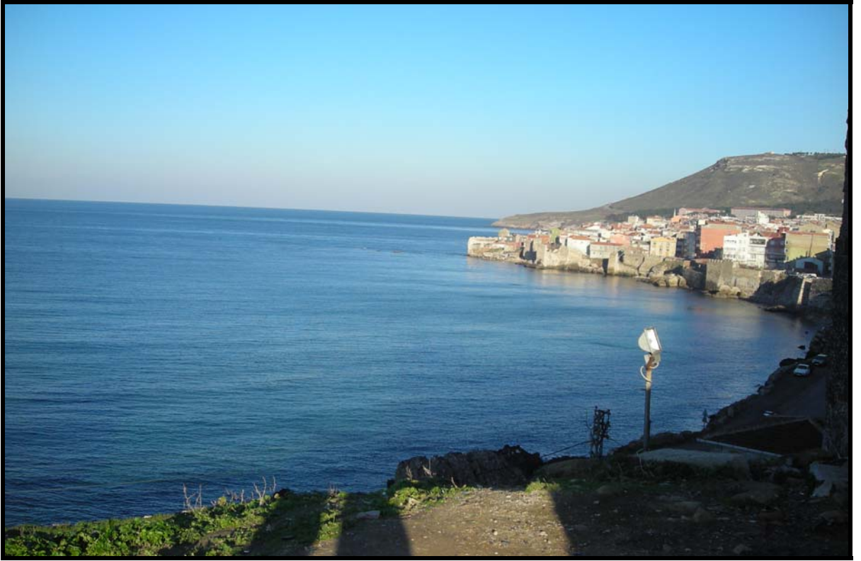
Şekil 4.32 Kısmen yıkılmış, kısmen tahrip olmuş, kısmen de günümüze kadar korunabilmiş Sinop Surları
