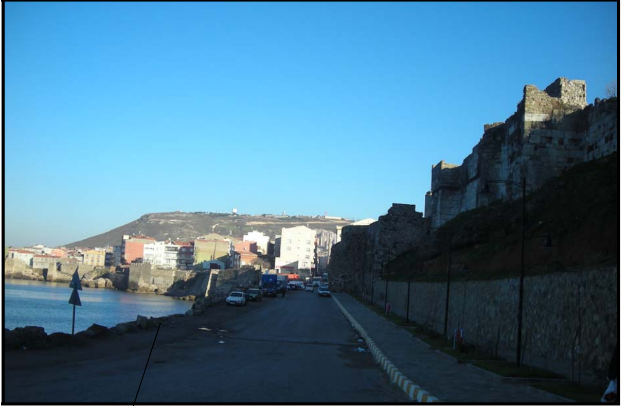
Şekil 4.30 Yol yapımı esnasında denizin doldurulması suretiyle yıkılan Sinop Surları
