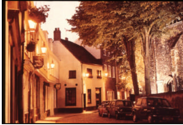
Sekil 4.23 Yapi yüzlerine tespit edilen aydınlatma elemanı örneği
