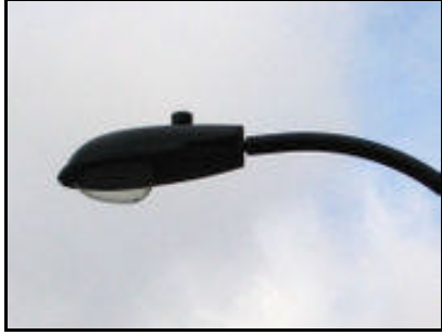
Sekil 5.9 Geometrik özellikleri isigin yanlara kaçmasına izin veren bir aydinlatma elemani
