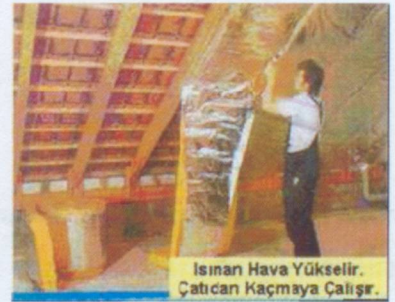
Şekil-5.3: Yalıtım Yapılmasına ilişkin Örnekler
