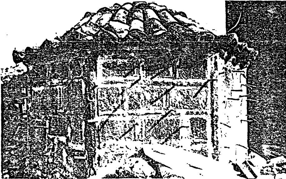
Fotoğraf 12: Holy Aposles Kilisesi'nde Çimento Enjeksiyon Kullanımı ( Vogiatzis'den).
