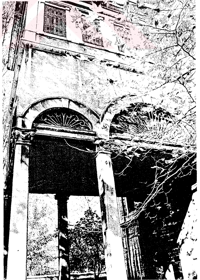
Fotoğraf 3.8 HK 10 Güneydoğu görünüşü
