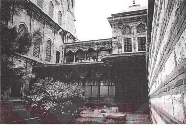
Fotoğraf 2.21 HK 4 Güneydoğu görünüşü
