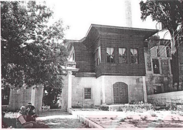
Fotoğraf 2.115 EHK 3 Güneydoğu görünüşü
