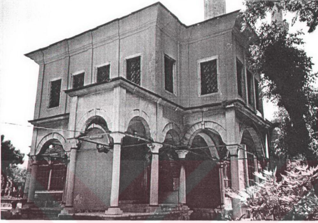
Fotoğraf 2.40 HK 8 Kuzeydoğu görünüşü
