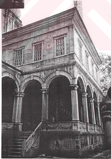
Fotoğraf 2.55 HK 10 Kuzeydoğu görünüşü
