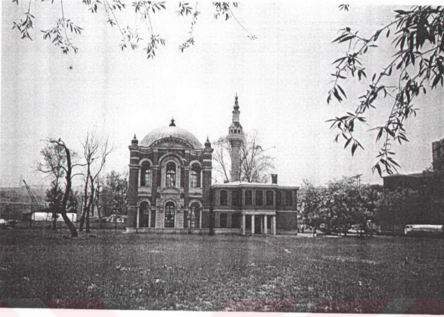
Fotoğraf 2.84 Kuzeydoğu görünüşü
