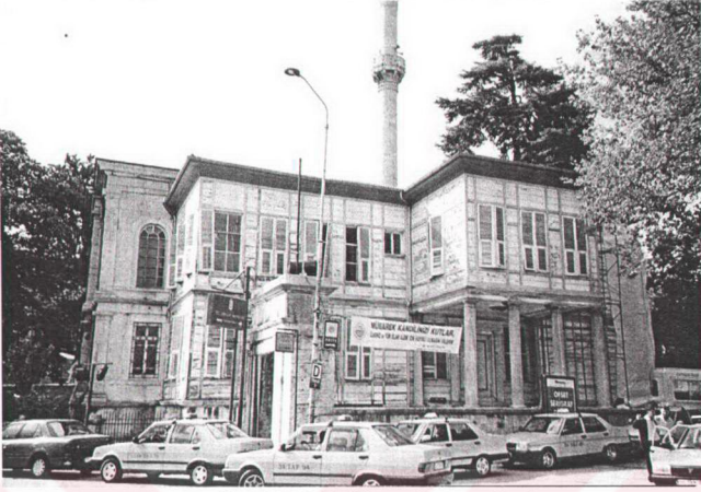
Fotoğraf 2.58 HK 11 Kuzeydoğu cephesi
