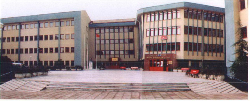
Şekil 6.35 Türkan Sabancı Görme Engelliler İlköğretim Okulu'nun idare, pansiyon ve eğitim blokları ana girişi
