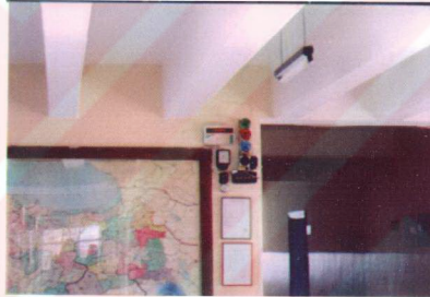
Şekil 6.40 İşitme engelli öğrenciler için zilin yanında bulunan ışıklı uyarı sistemi
